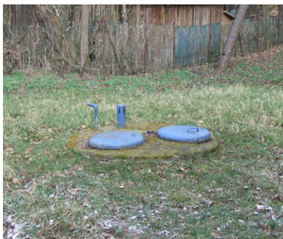
Fot. 1. Istniejące studnie głębinowe.
