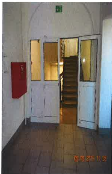
Widok klatka K2 Ip..drzwi EI 30 kondygnacja , brak samozamykaczy, HP 25 z odcinkiem węża 30m
