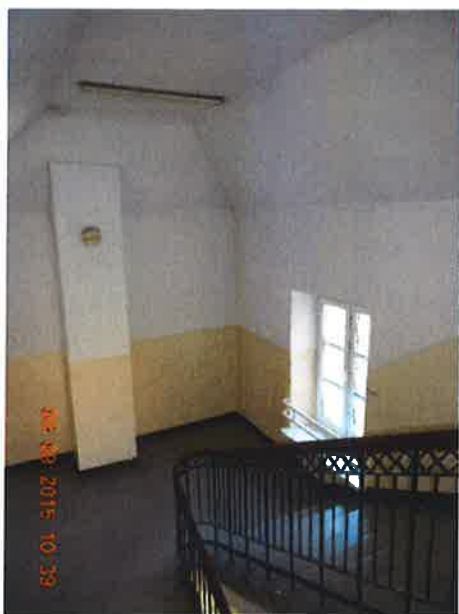
Widok góra klatki K1 konieczność wykonania otworu do oddymiania w stropie klatki, okno za nisko położone przy spoczniku
