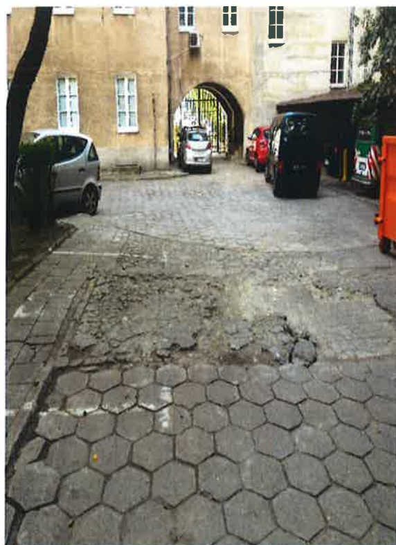
Widok uszkodzonej nawierzchni drogi pożarowej.
