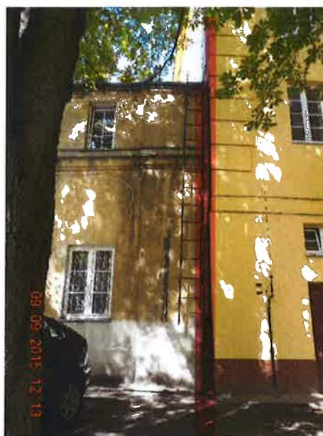
Widok dziedziniec styku łącznika 2 kond. z budynkiem DS Pineska, REI 120 na całej wysokości
