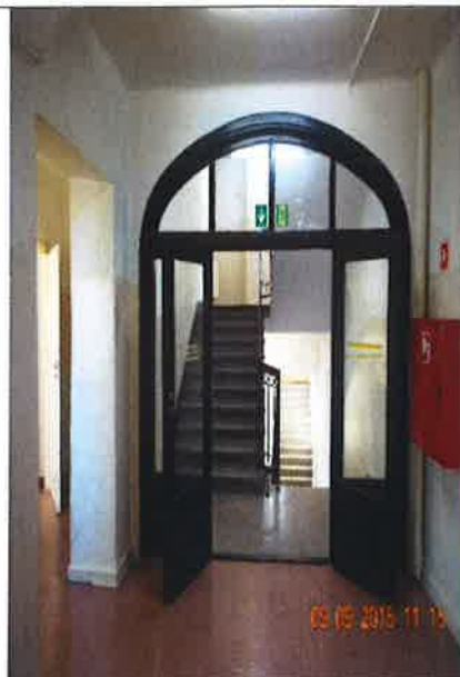
Widok klatka K1 piętra II i III drzwi bezklasowe wejście do klatki schodowej, wymieniono hydranty na HP 25 z 30m odcinkiem węża półsztywnego
