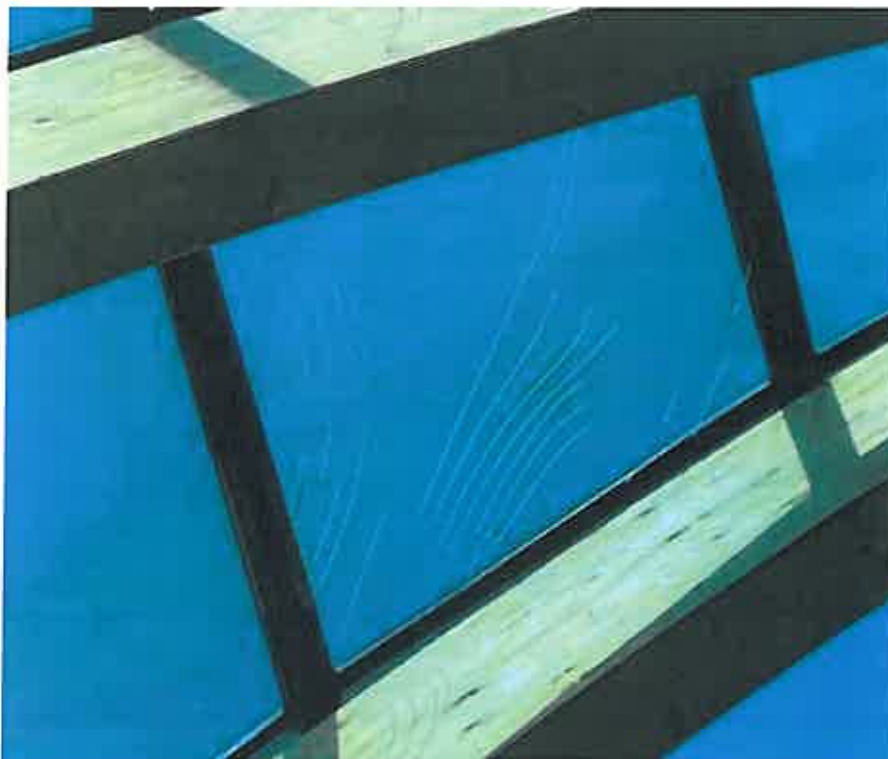
Zdjęcie nr 1. Pęknięta szyba „szklanej kuli”
