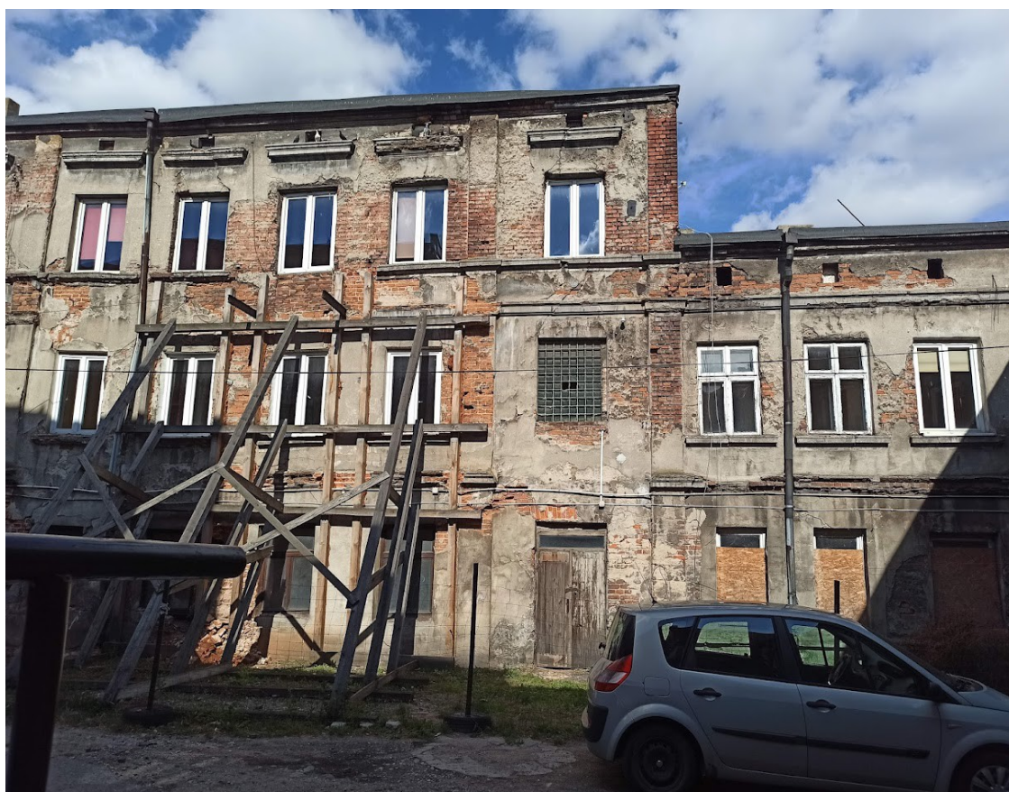
ELEWACJA FRONTOWA-ZNISZCZENIA ELEWACJI, PODPARCIE ELEWACJI DREWNIANĄ KONSTRUKCJĄ
