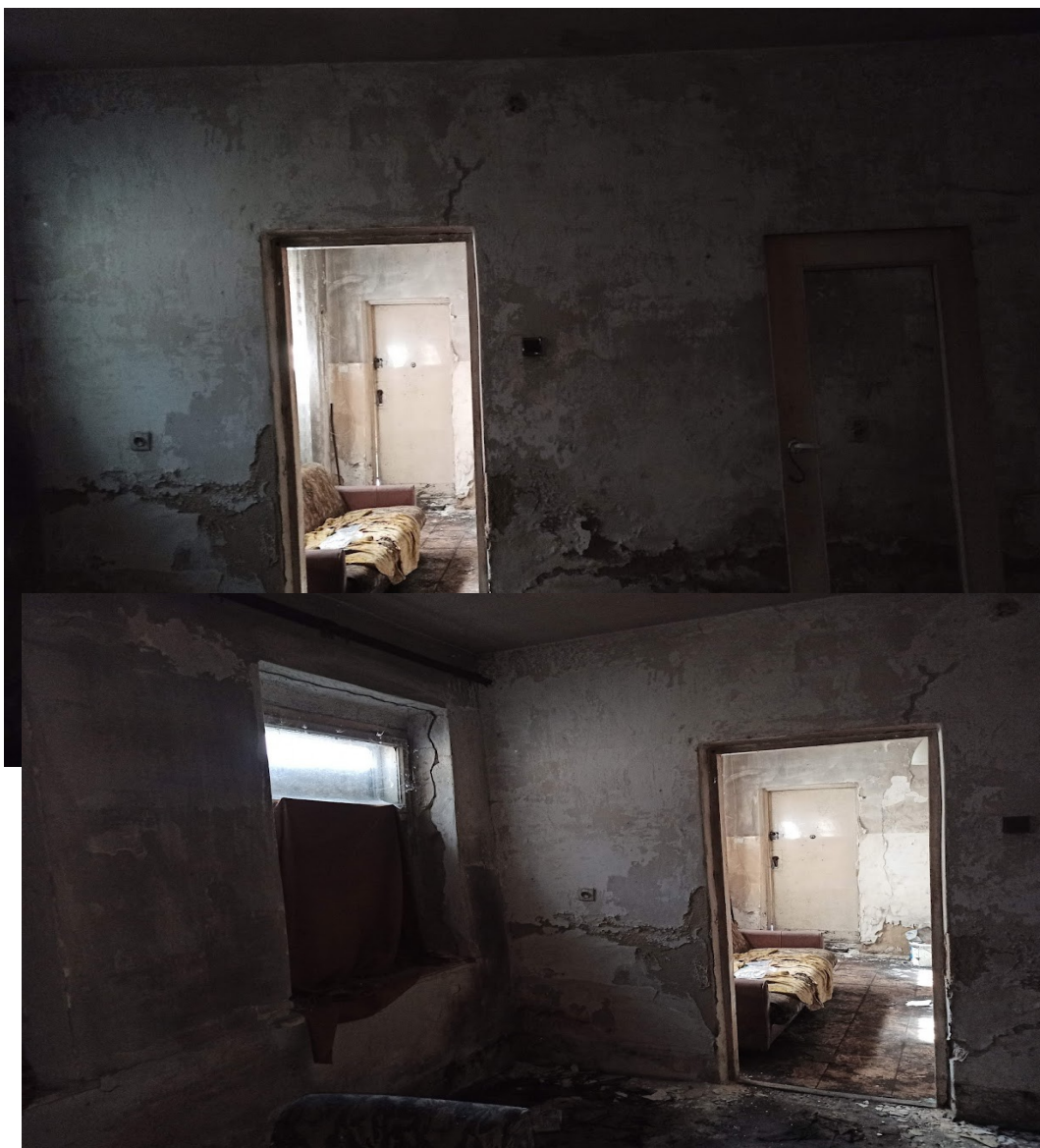
POMIESZCZENIA WEWNĄTRZ BUDYNU-ODPSOJENIA TYNKU, ZAWILOCENIA ŚCIAN
