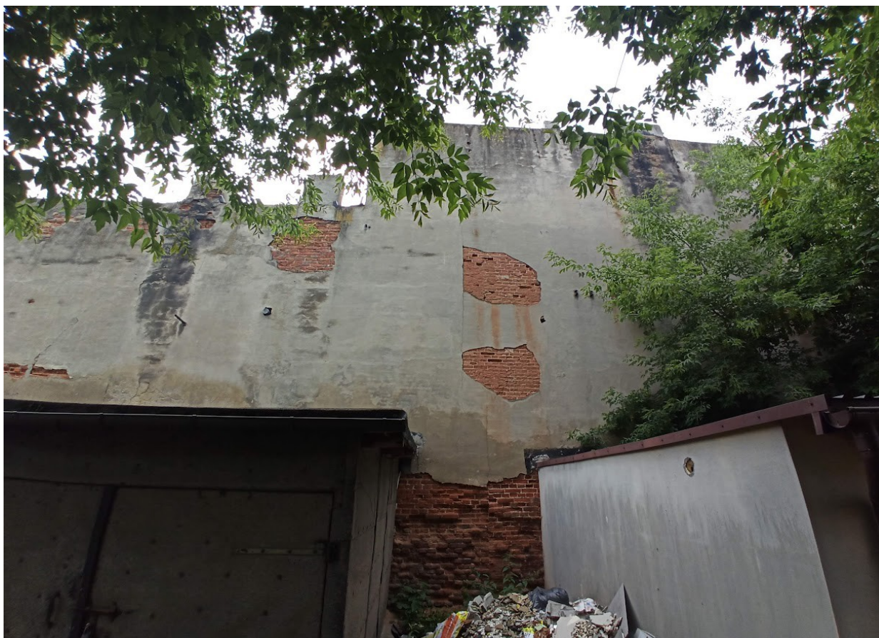
ELEWACJA TYLNA - WIDOCZNA DEGRADACJA MURU - ZAWILGOCENIA ORAZ NIEWŁAŚCIWIE DOBRANE SPOIWO PRZYSZYLIŁY SIĘ DO POSTĘPUJĄCEGO ZUŻYCIA MURU
