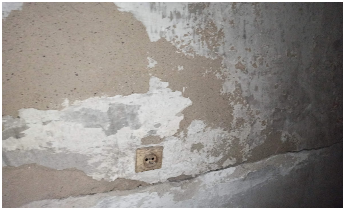
ZAWILGOCENIA W NAROŻNIKACH BUDYNKU
