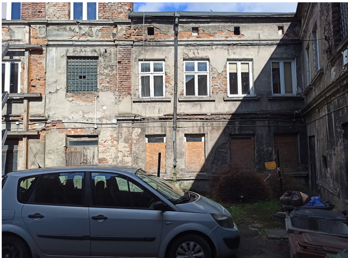
ELEWACJA TYLNA - WIDOCZNA DEGRADACJA MURU - ZAWILGOCENIA ORAZ NIEWŁAŚCIWIE DOBRANE SPOIWO PRZYSZYLIŁY SIĘ DO POSTĘPUJĄCEGO ZUŻYCIA MURU
