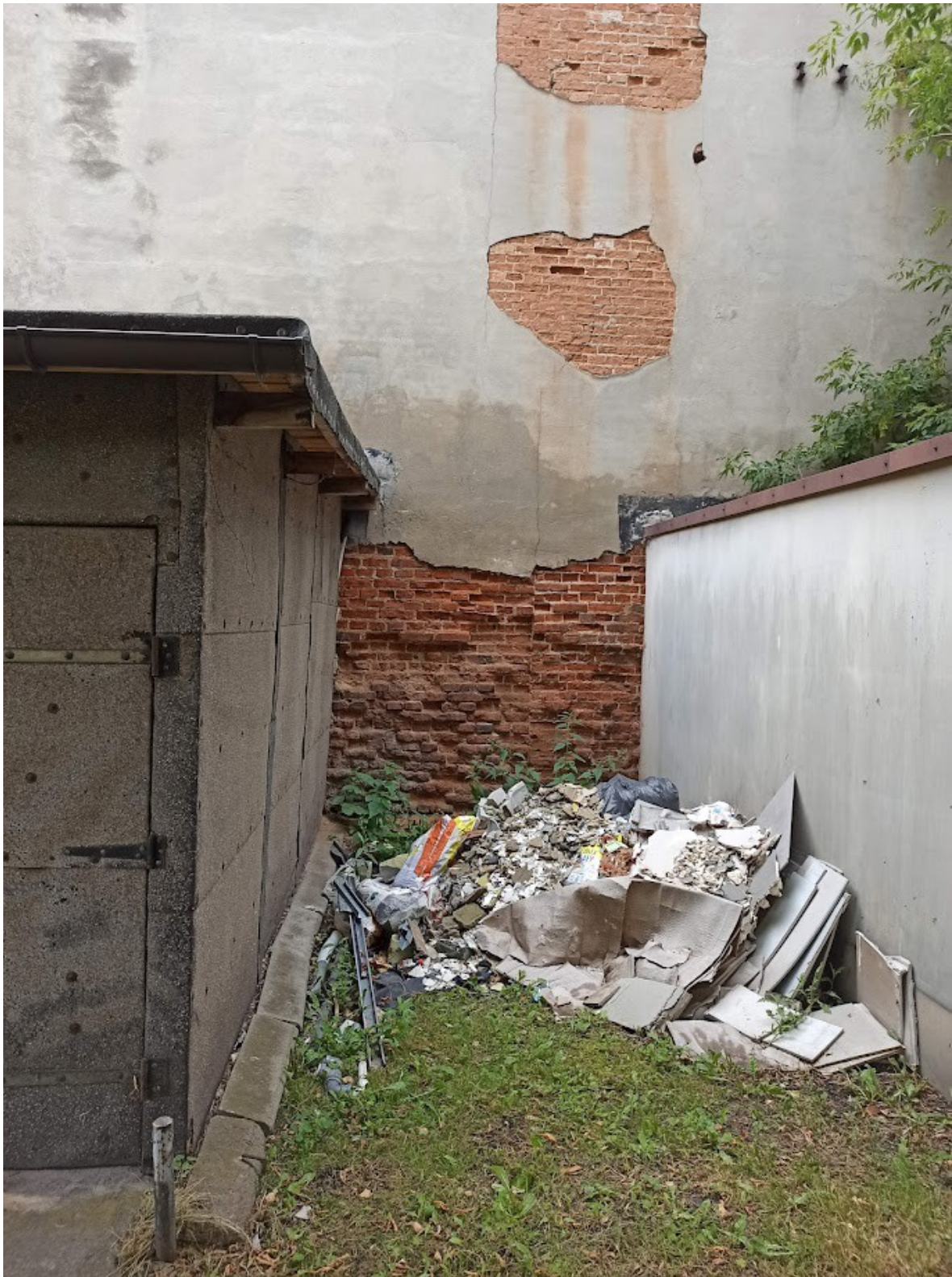
ELEWACJA TYLNA - ODPSOJENIA TYNKU - MIĘDZY BUDYNKAMI GARAŻY, WIDOCZNA DEGRADACJA MURU
