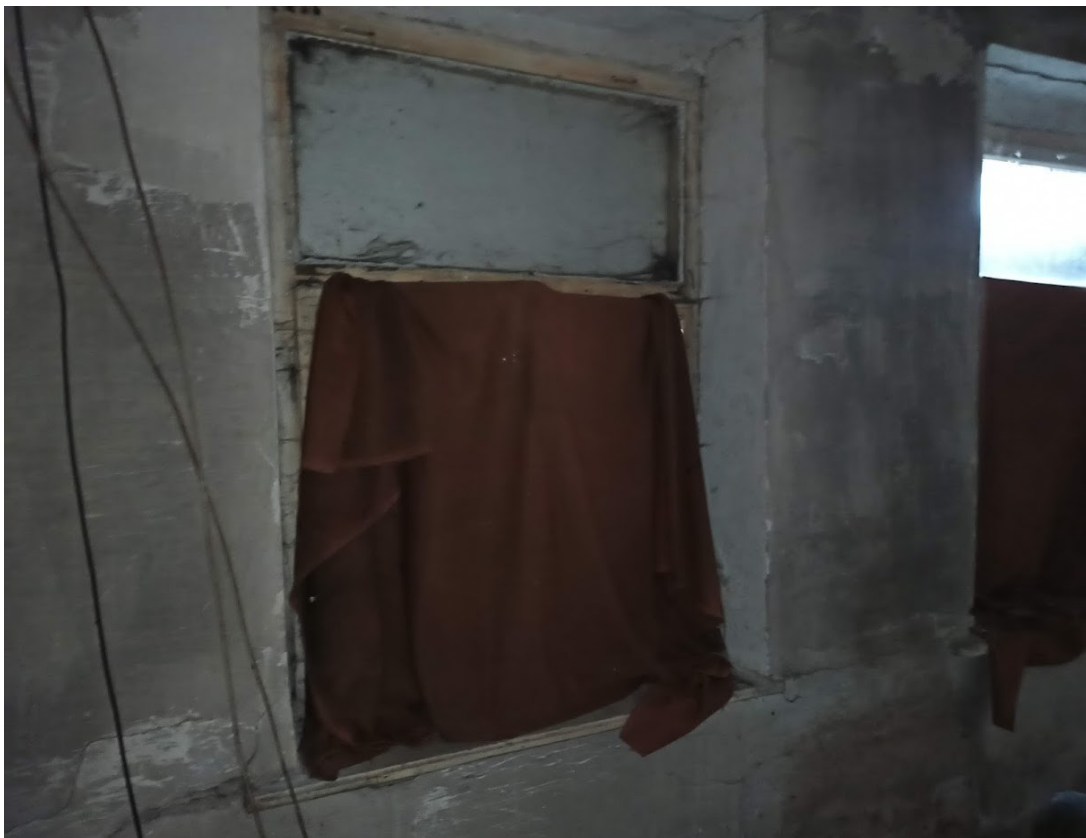
POMIESZCZENIA WEWNĄTRZ BUDYNU-ODPSOJENIA TYNKU, ZAWILOCENIA ŚCIAN
