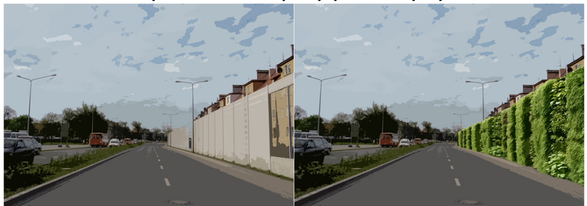
Ryc. 10. Roślinna ściana jako żywy ekran akustyczny przy jezdni
