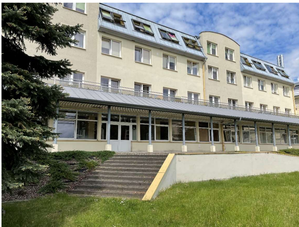
Fot 1. Widok tarasu
