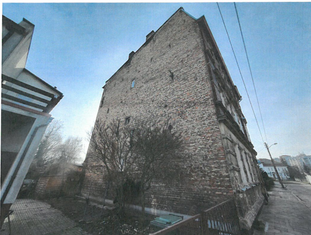
Fot. 8 Ściana szczytowa wschodnia – brak nisz jakichkolwiek chronionych gatunków.
