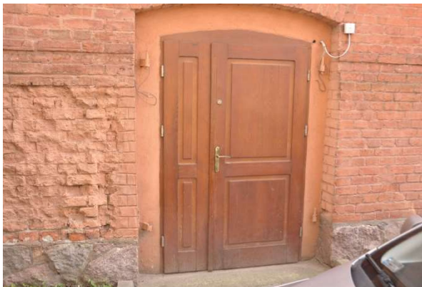
Fot. 20. Boczne wejście do obiektu od strony dziedzińca – wtórna konstrukcja stolarki drzwiowej
