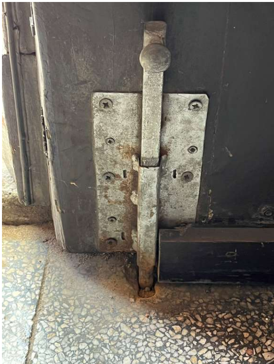
Fot. 14. Dolna zasuwa prawego skrzydła, aktualny stan zachowania
