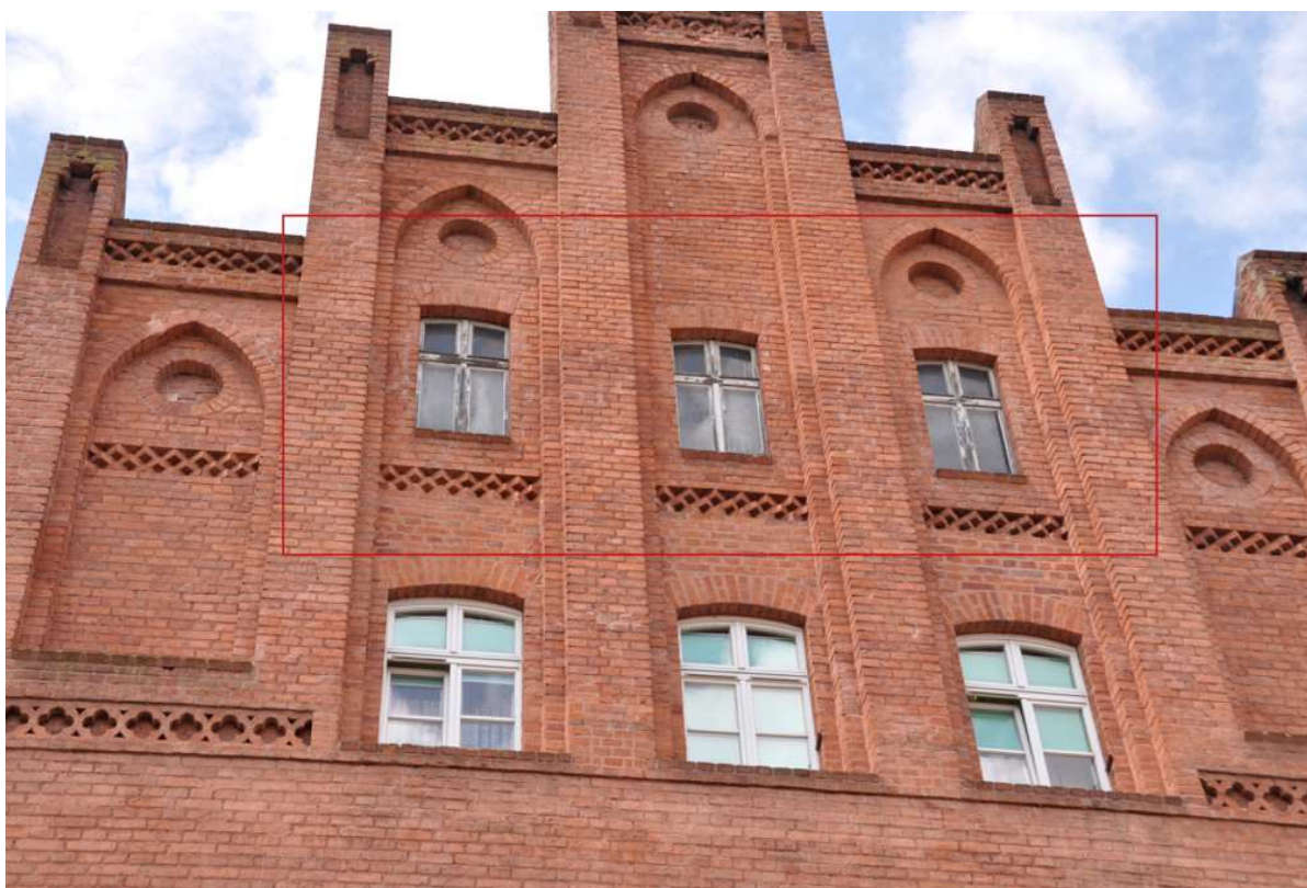
Fot. 30 Elewacja południowo-wschodniej, zaznaczone okna poddasza, aktualny stan zachowania.
