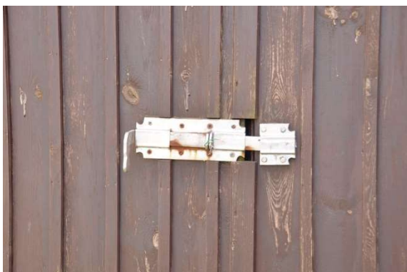
Fot. 28. Zasuwa pozioma – aktualny stan zachowania
