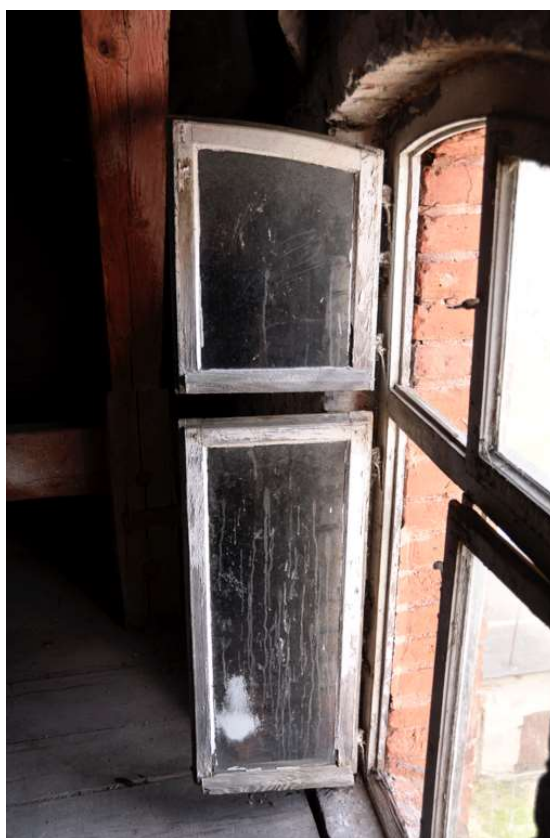
Fot. 32 Skrzydła okna w obrębie elewacji północno-zachodniej, aktualny stan zachowania
