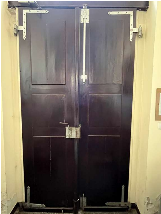
Fot. 12. Konstrukcja zawiasu, aktualny stan zachowania
