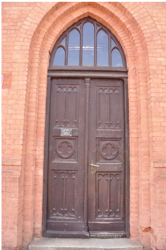
Fot. 1. Drzwi głównego wejścia -aktualny stan zachowania
