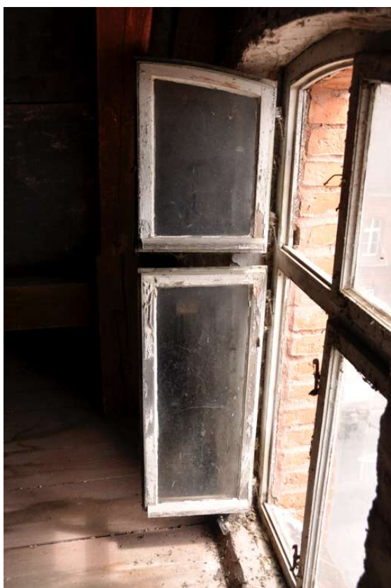
Fot. 31 Skrzydła okna w obrębie elewacji południowo-wschodniej, aktualny stan zachowania
