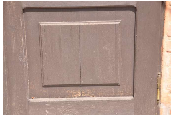
Fot. 19. Płycina prawego skrzydła z widocznymi ubytkami warstwy malarskiej oraz spękaniami konstrukcji
