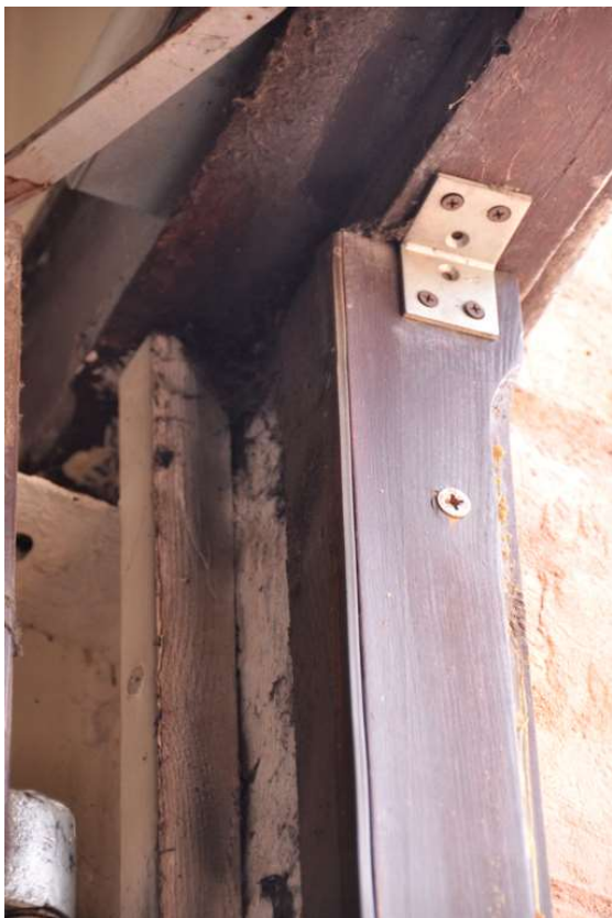
Fot. 6. Wtórnie dostawiona drewniana belka ościeża, pełniąca funkcję elementu doszczelniającego konstrukcję drzwi.
