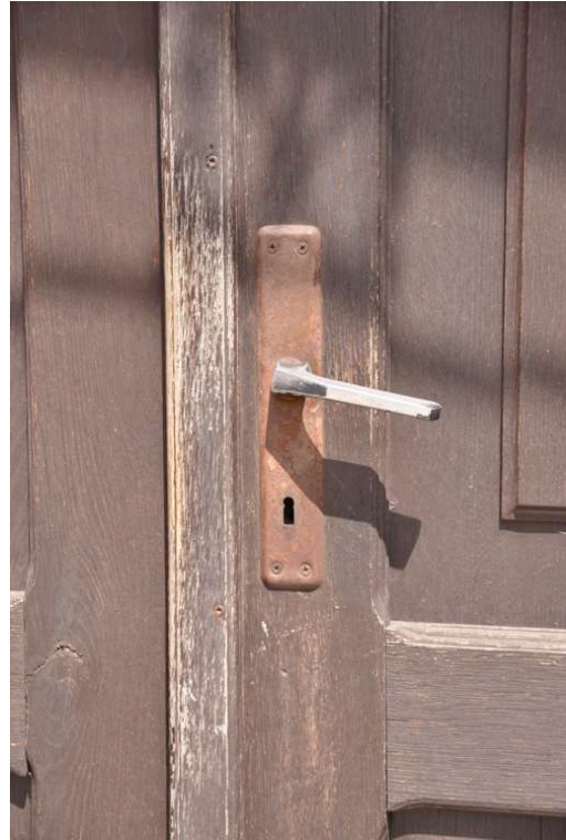
Fot. 17. Zbliżenie na klamkę drzwi, aktualny stan zachowania. Widoczny ubytek warstwy malarskiej zarówno klamki jak i listwy dymkowej oraz intensywna korozja szyldu.
