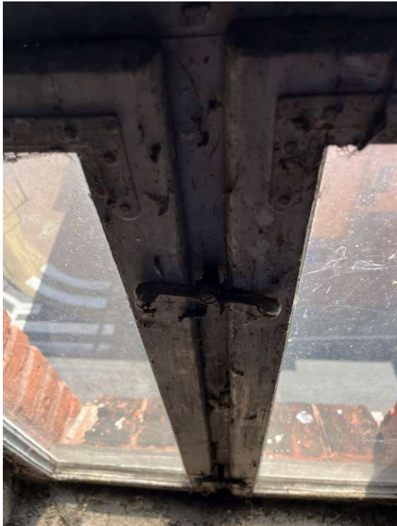
Fot. 33. Skrzydła okna w obrębie elewacji południowo-wschodniej, widok od środka, aktualny stan zachowania.
