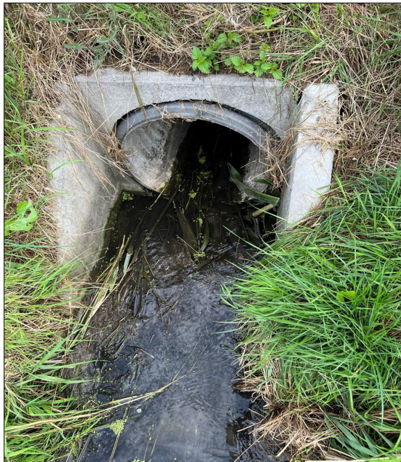
Fot. 32. Wylot przepustu pod ulicą Rosnowską
