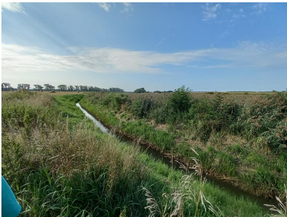
Fot. 2. Koryto rowu WA-1 w km ca 0+050
