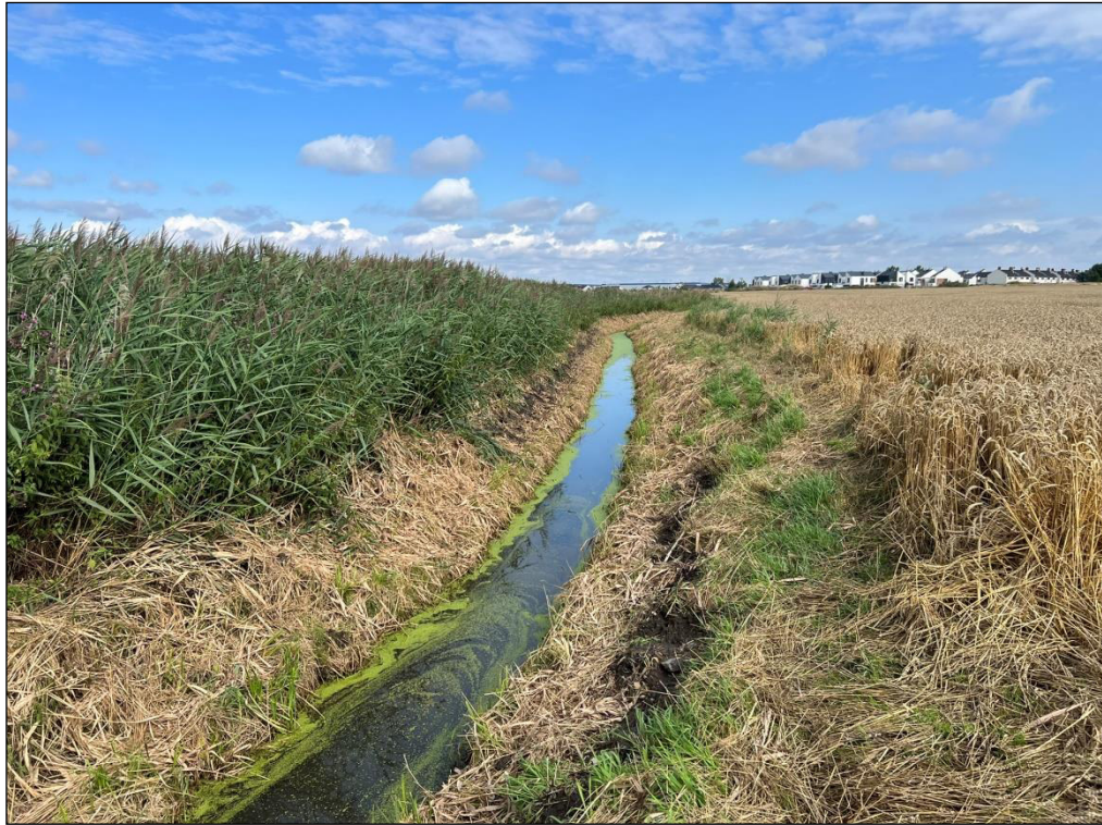
Fot. 5. Koryto rowu WA-1 w km ca 0+400 – widok w kierunku ujścia
