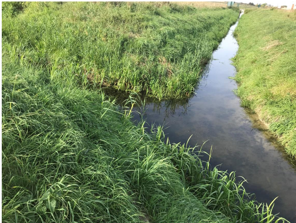
Fot. 1. Koryto rowu WA-1 na ujściu do Dopywu z Dopywca
