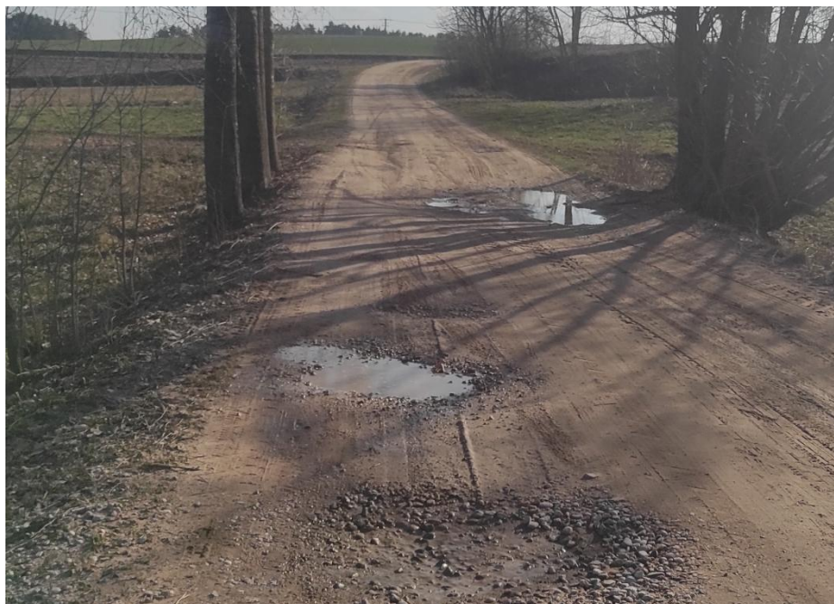
Rys. 5 Stan nawierzchni na odcinku 0-222m.
