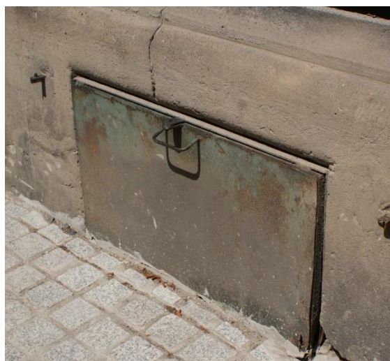
Kalpa metalowa okienka piwnicznego
