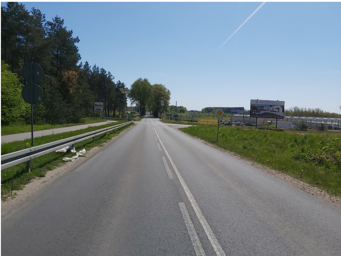
Rysunek 5: Widok drogi 2707G od strony m. Linowiec
