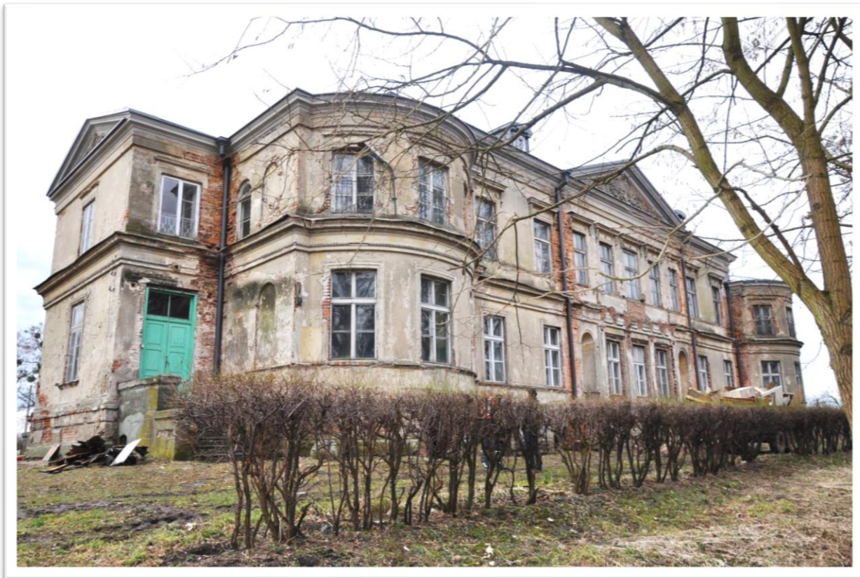
Fotografia .4 Widok elewacji tylnej 2022 rok.
