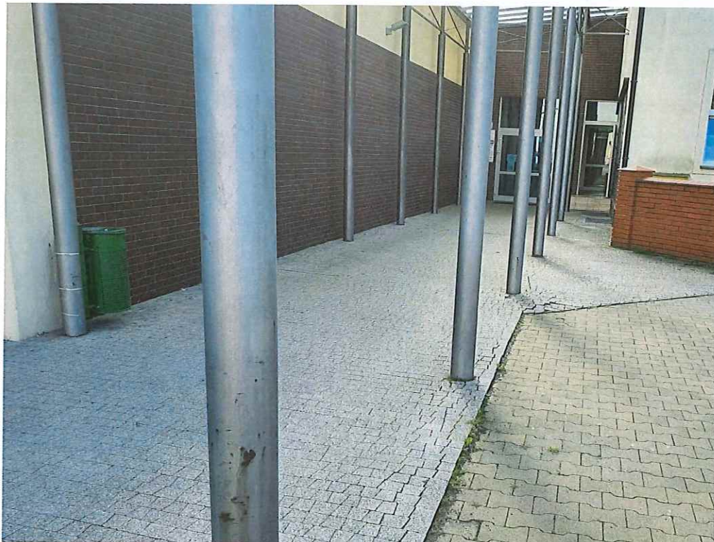
Główne wejście – kostka „piccolo” do wymiany, słupy do malowania
