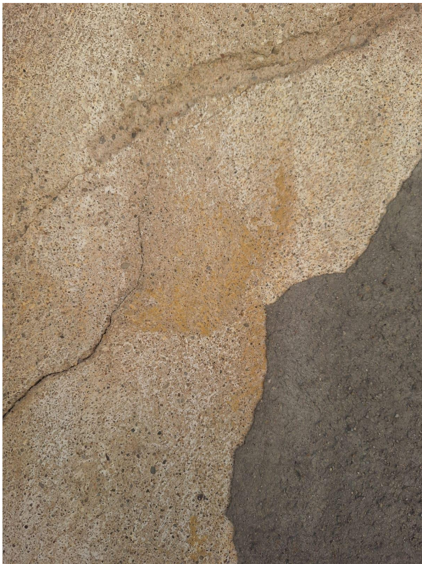
9,10. Elewacja południowa kościoła. Widoczne warstwy pierwotne tynku wapienno- piaskowego z zachowaną częściowo ugrową warstwą malarską
