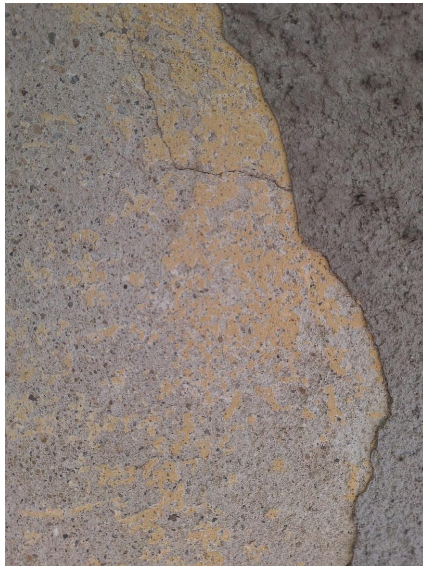
9,10. Elewacja południowa kościoła. Widoczne warstwy pierwotne tynku wapienno- piaskowego z zachowaną częściowo ugrową warstwą malarską
