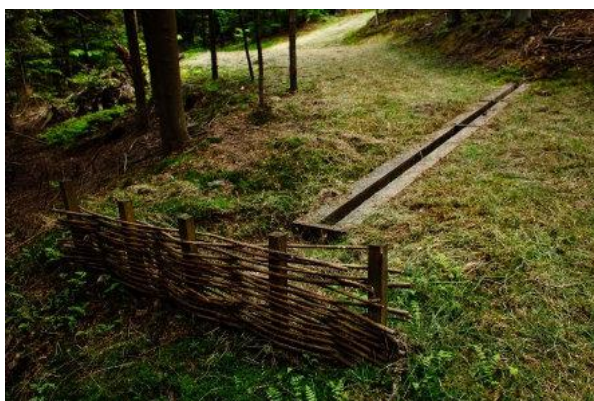
Płotki faszynowe antyerozyjne rozpraszające wodę na stok. Źródło: Archiwum CKPŚ.
