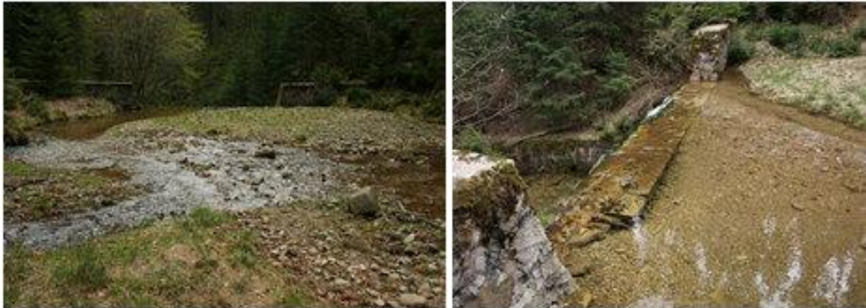
Rumosz różnych frakcji zalegający w czaszy różnych zapór – Nadleśnictwo Łądek Zdrój. Źródło: Archiwum CKPŚ.
