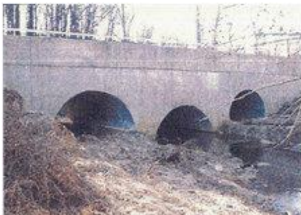
Przykłady wielootworowych przepustów z rezerwową przepustowością na wody powodziowe. Źródło: „Metody hydraulicznego projektowania przepustów z uwzględnieniem morfologii cieku i wymogów związanych ze swobodnym przepływem ryb.” A.J. Kosicki w „Hydraulika, hydrologia, hydrogeologia”
