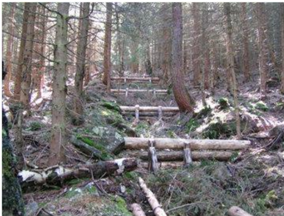
Przegrody drewniane wypełnione gałęziówką na szlakach zrywkowych
