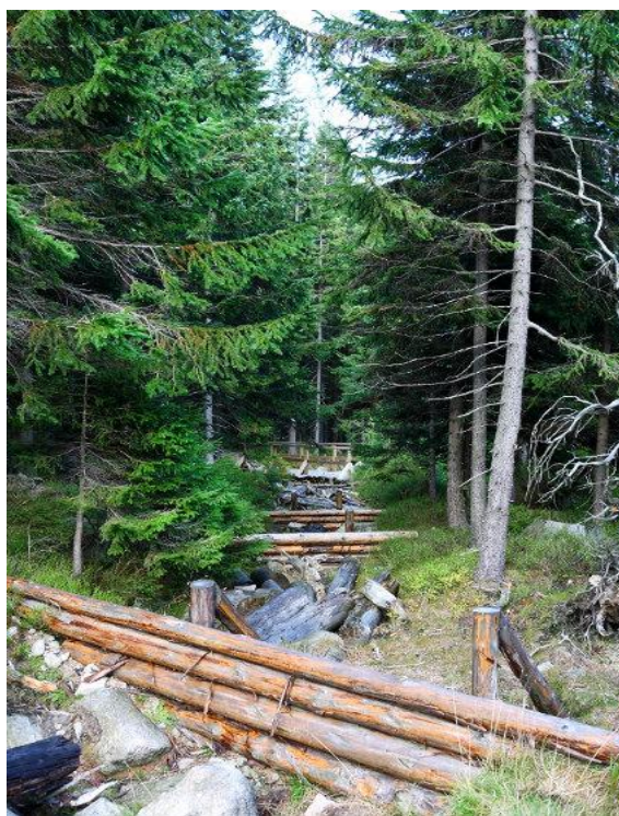
Dawny, zrenaturyzowany szlak zrywkowy zabezpieczony przed spływem powierzchniowym.
