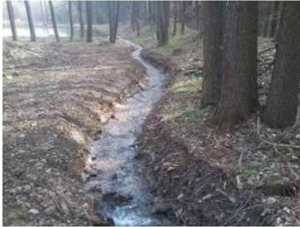
Kanał ziemny łączący 2 zbiorniki (N-ctwo Świdnica)
