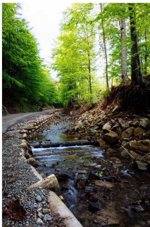
Poniżej progu widoczne są dwa „baseny”, prog pośredni i gurt. Niestety próg nie ma przelewu na małą wodę. Źródło: Archiwum CKPŚ.
