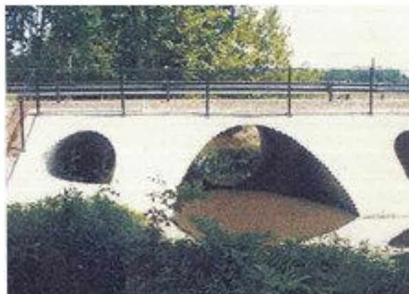
Przykłady wielootworowych przepustów z rezerwową przepustowością na wody powodziowe. Źródło: „Metody hydraulicznego projektowania przepustów z uwzględnieniem morfologii cieku i wymogów związanych ze swobodnym przepływem ryb.” A.J. Kosicki w „Hydraulika, hydrologia, hydrogeologia”
