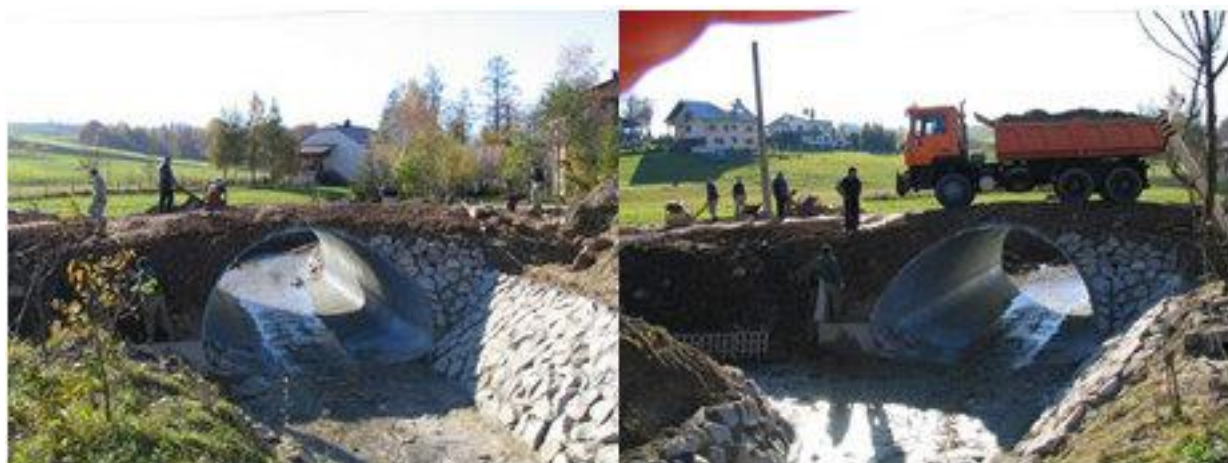
Przykłady adaptacji przepustów do zmian klimatu.
