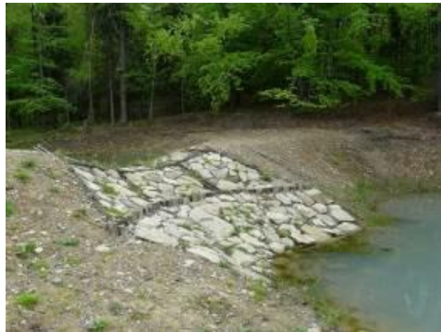
Przelewy górne w zbiornikach w N-ctwie Bielsko
