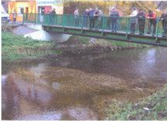
Utworzona sztuczne łacha żwirowa. Źródło: J. Nyk, J. Domagała „Sztuczne tarliska dla ryb...” w „Użytkownik rybacki nowa rzeczywistość” Spała 2008 r.
