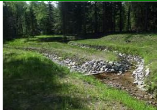
Podział wody na ciek główny – dolot do zbiorników bocznych w N-ctwie Szklarska Poręba. Zródło: Archiwum CKPŚ.
