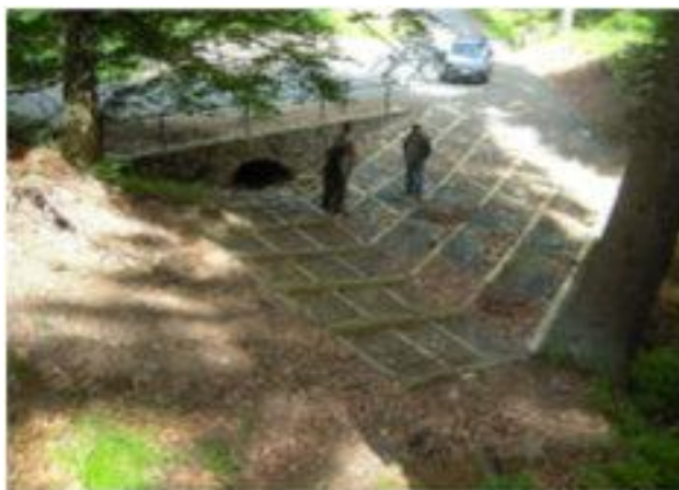
Kratownica drewniana poniżej przepustu pod drogą gminną – kratownica pełni rolę ubezpieczenia wypadu i jednocześnie brodu umożliwiającego wjazd droga leśna pod górę – Nadleśnictwo Zdroje fot. R.Majewicz
