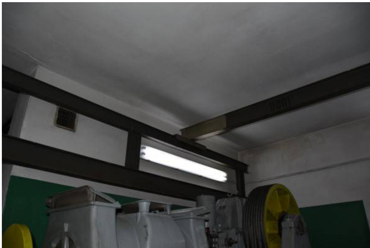
Stropdach pomieszczenia, belka do napraw dźwigu
