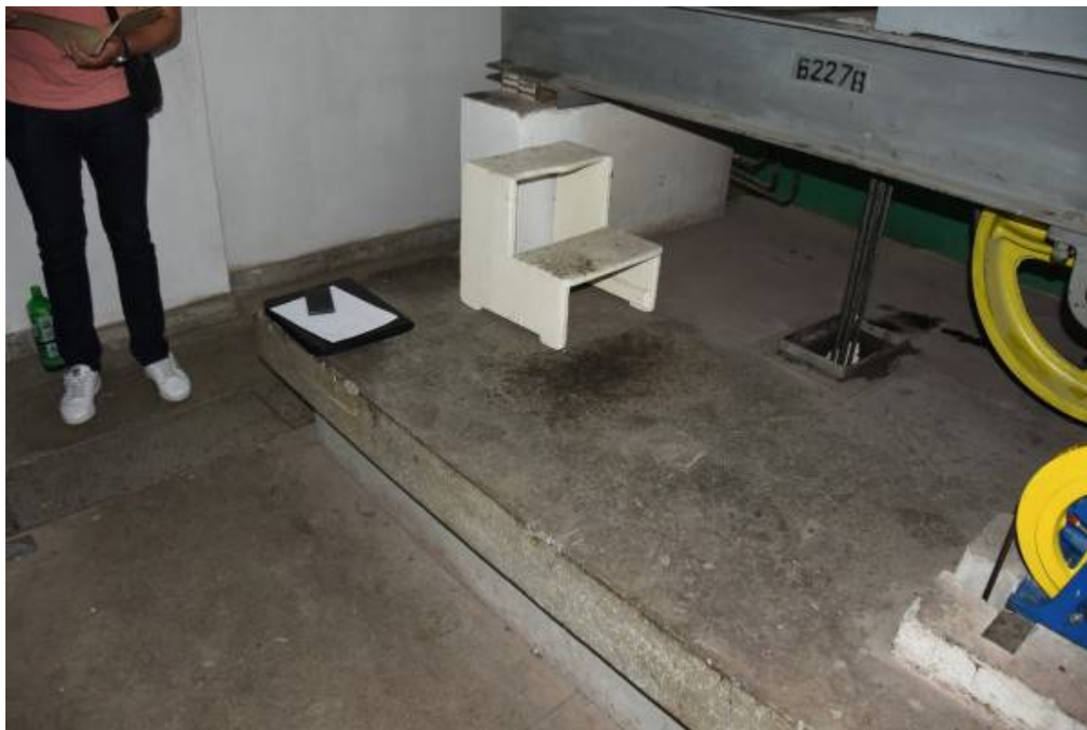
Płyta nadszybia, mocowanie dźwigu na belkach stalowych i postumentach
