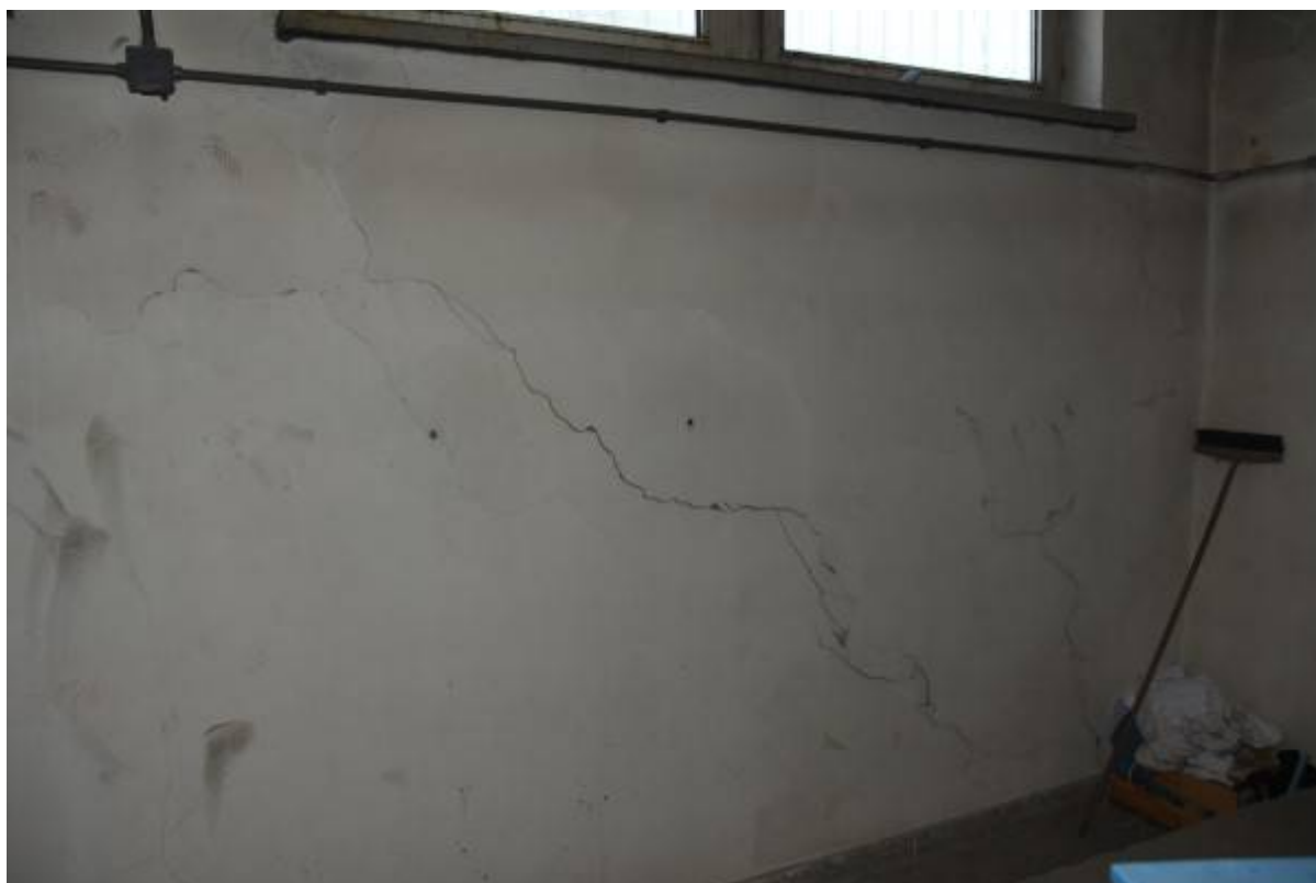
Zarysowanie ukośne ściany pomieszczenia pod oknami
