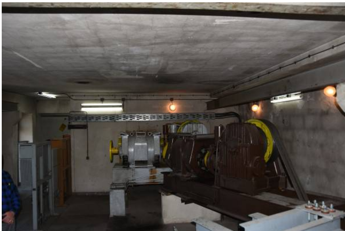
Widok pomieszczenia maszynowni z dźwigami na postumentach i belkami suwnicy
