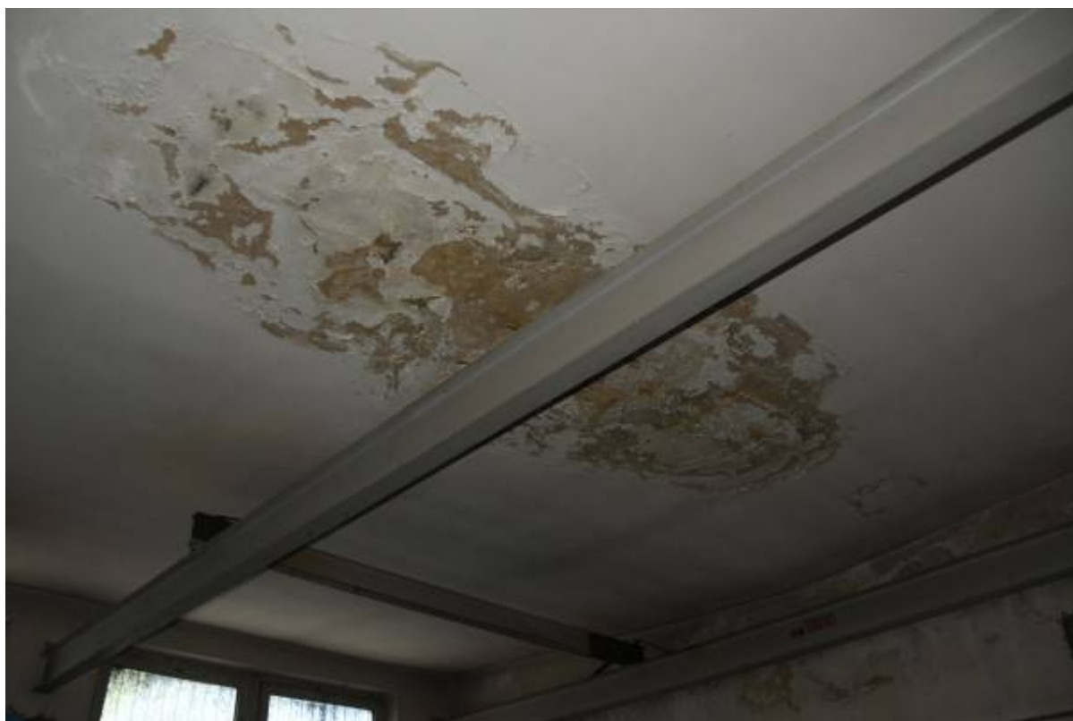
Stropodach pomieszczenia, belka do napraw dźwigu, zacieki w miejscu maksymalnego ugięcia stropu
