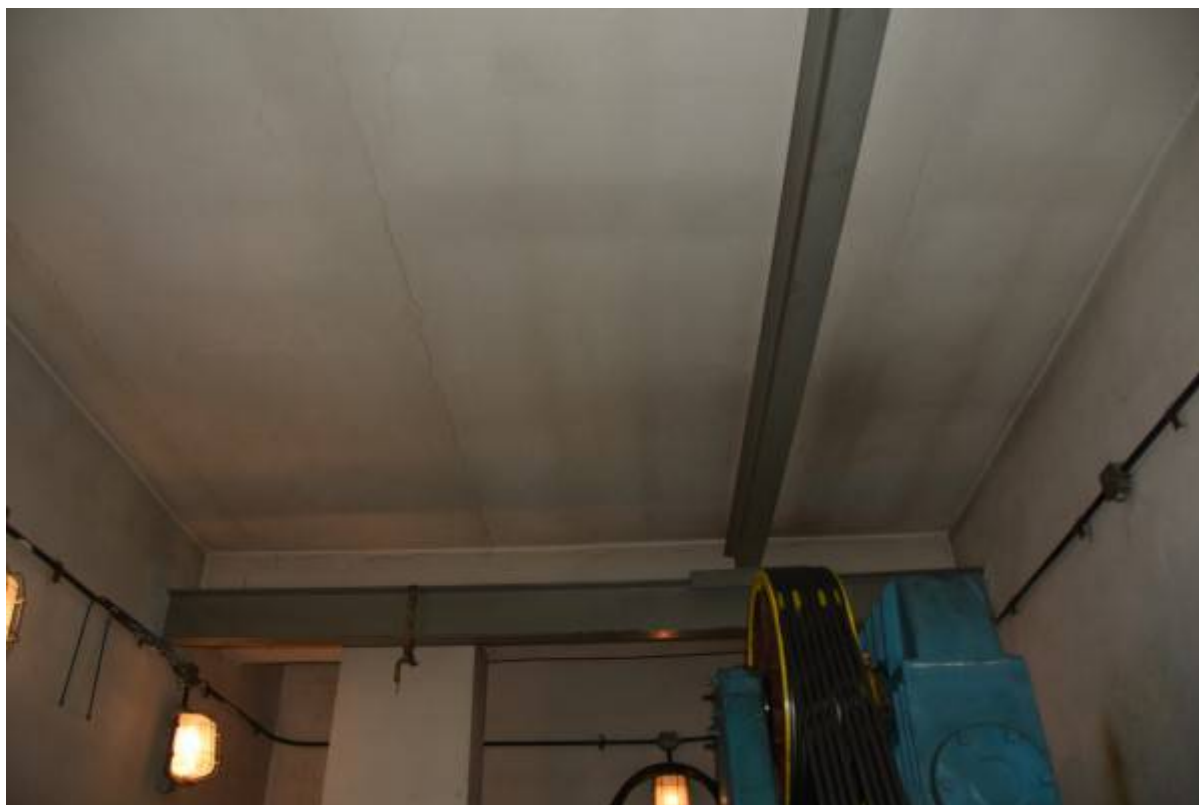
Stropodach pomieszczenia, belka do napraw dźwigu
