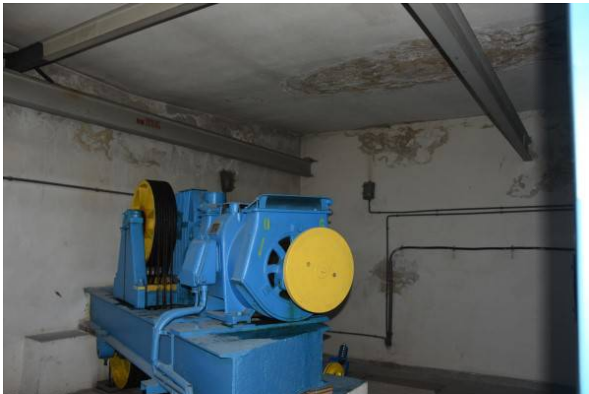
Widok pomieszczenia maszynowni i dźwigu, zacieki na ścianach i stropodachu
