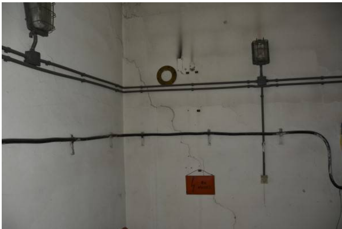
Zarysowanie ukośne ściany pomieszczenia
