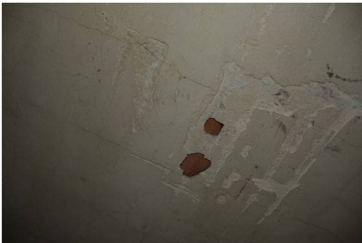
Uszkodzenia mechaniczne sufitu i pustaków stropowych stropodachu
