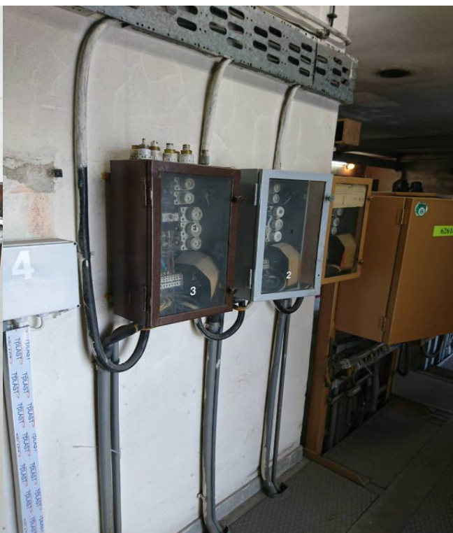
Przykładowe tablice zasilające dźwigi.
