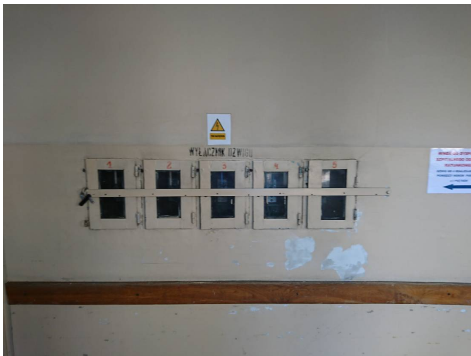
Parter wyłącznik dźwigu 1-5.
