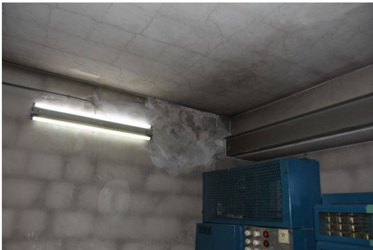
Zacieki na ścianie elewacyjnej pomieszczenia
