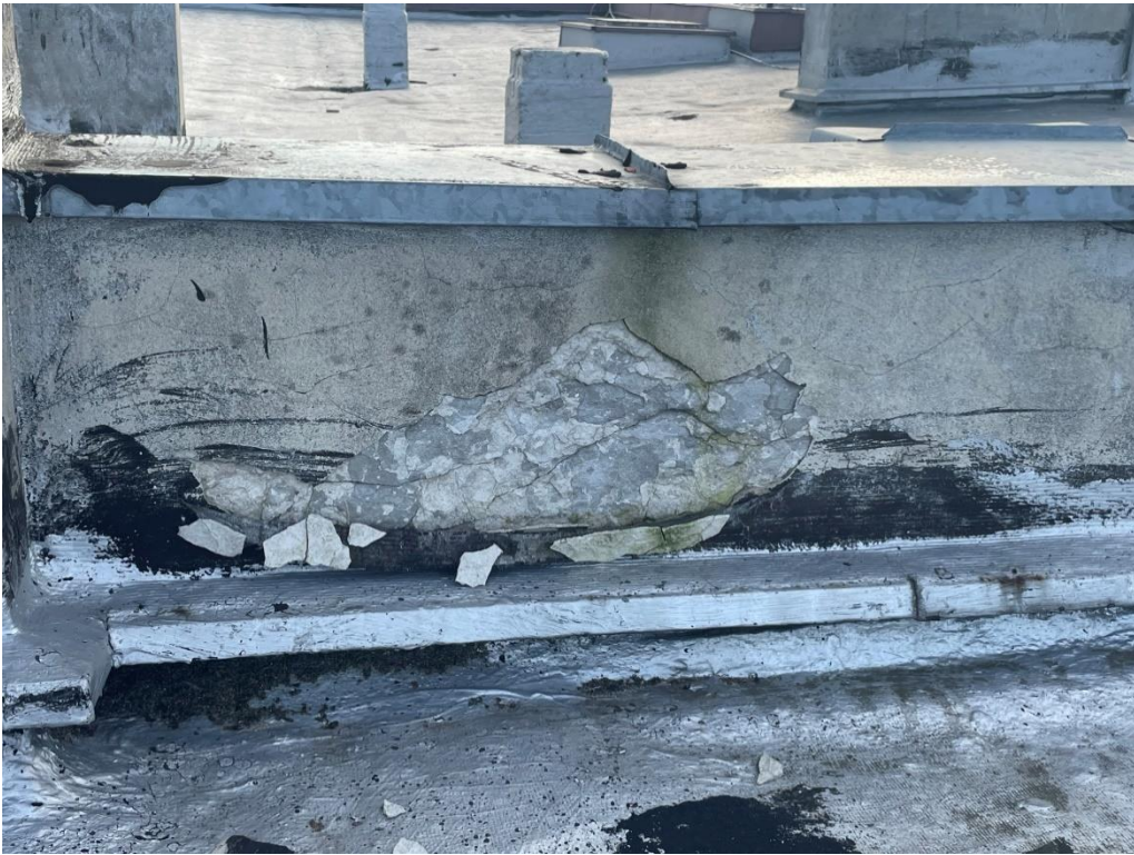
Odpadający tynk od ścian
