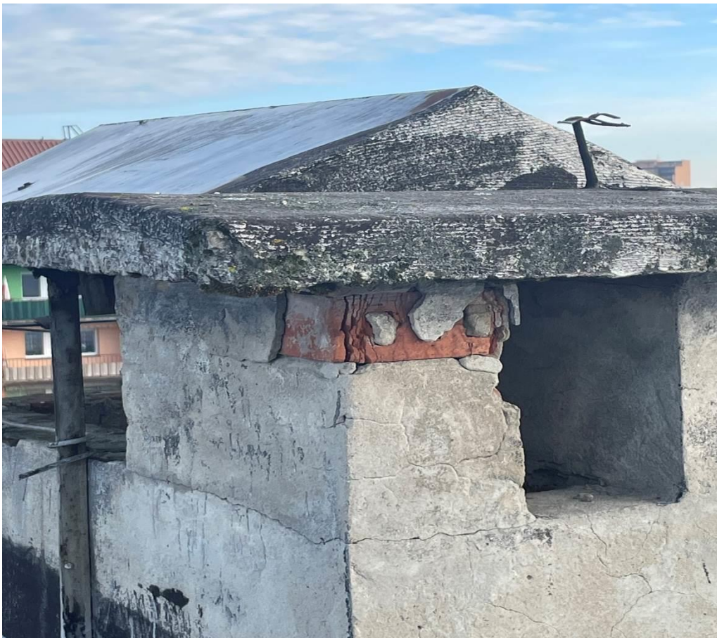
Odpadający tynk od ścian
