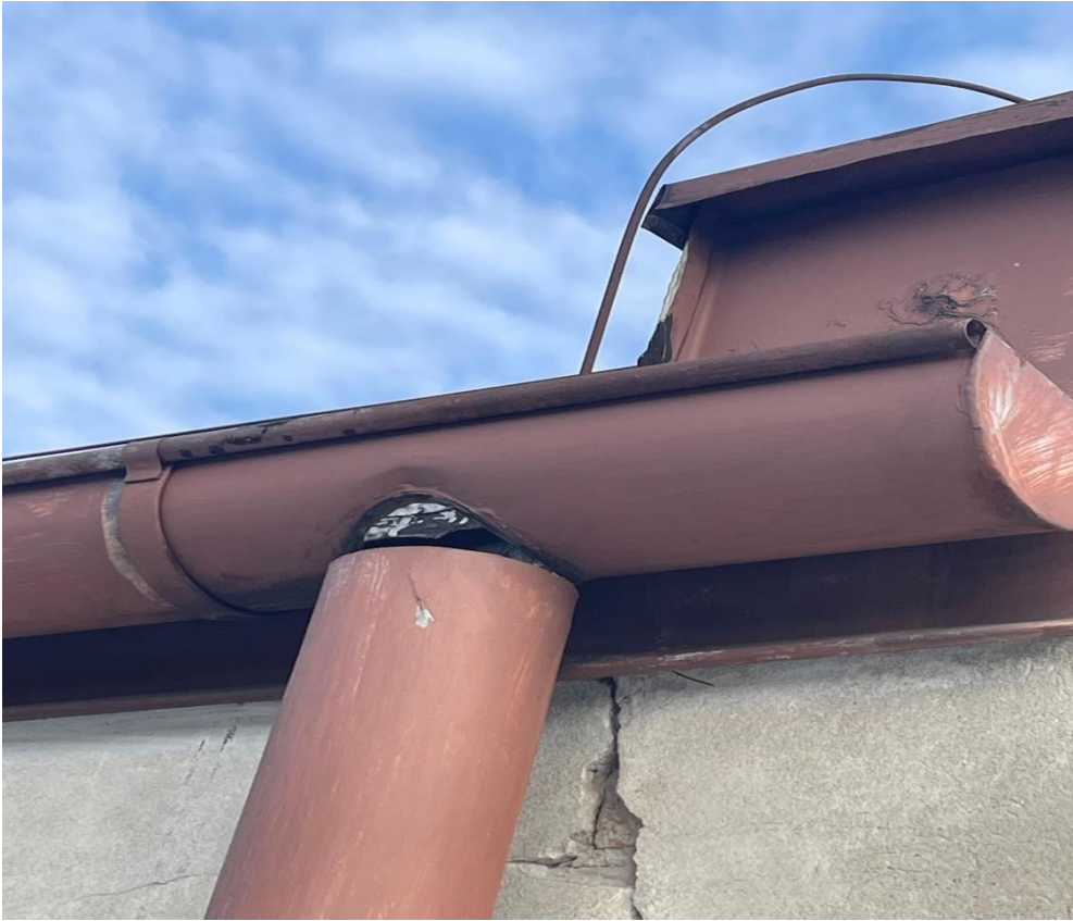
Oberwana rura spustowa
