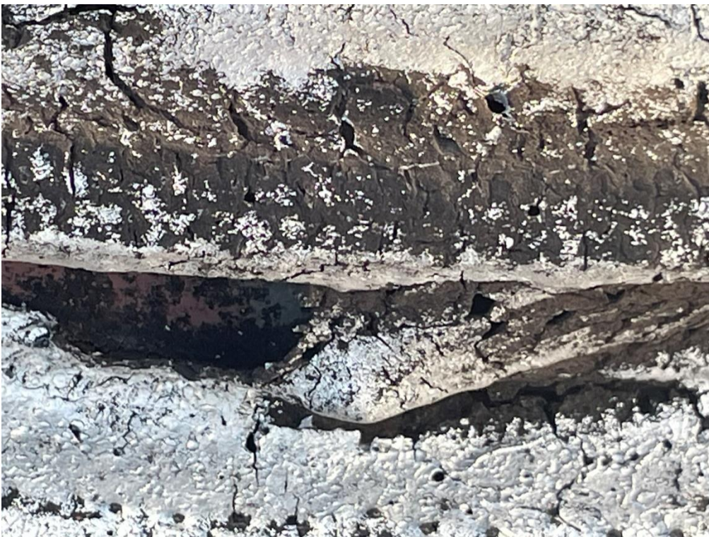
Widoczna nieszczelność poszycia
