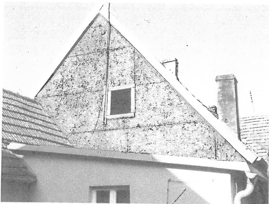
Fot. 13 Zabudowa szczytu płytą OSB wyższego członu od strony ul. Browarnej.
