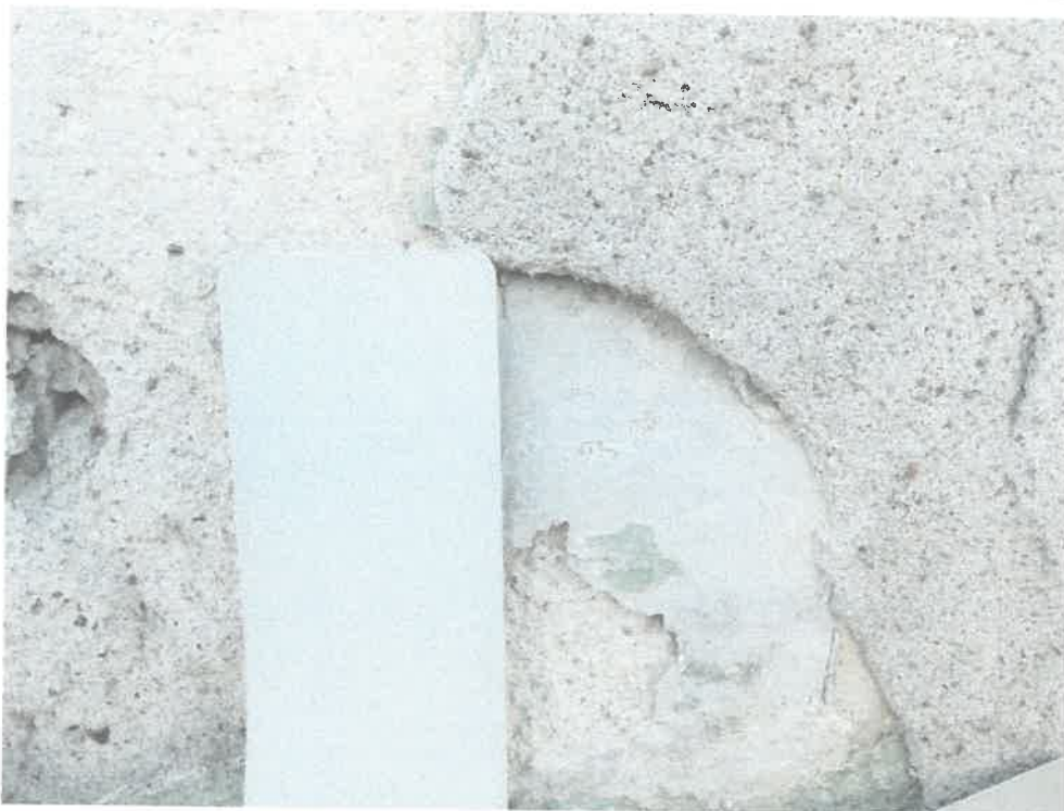
Szara powłoka malarska z przyłożonym wzornikiem z kolorem S 168.
