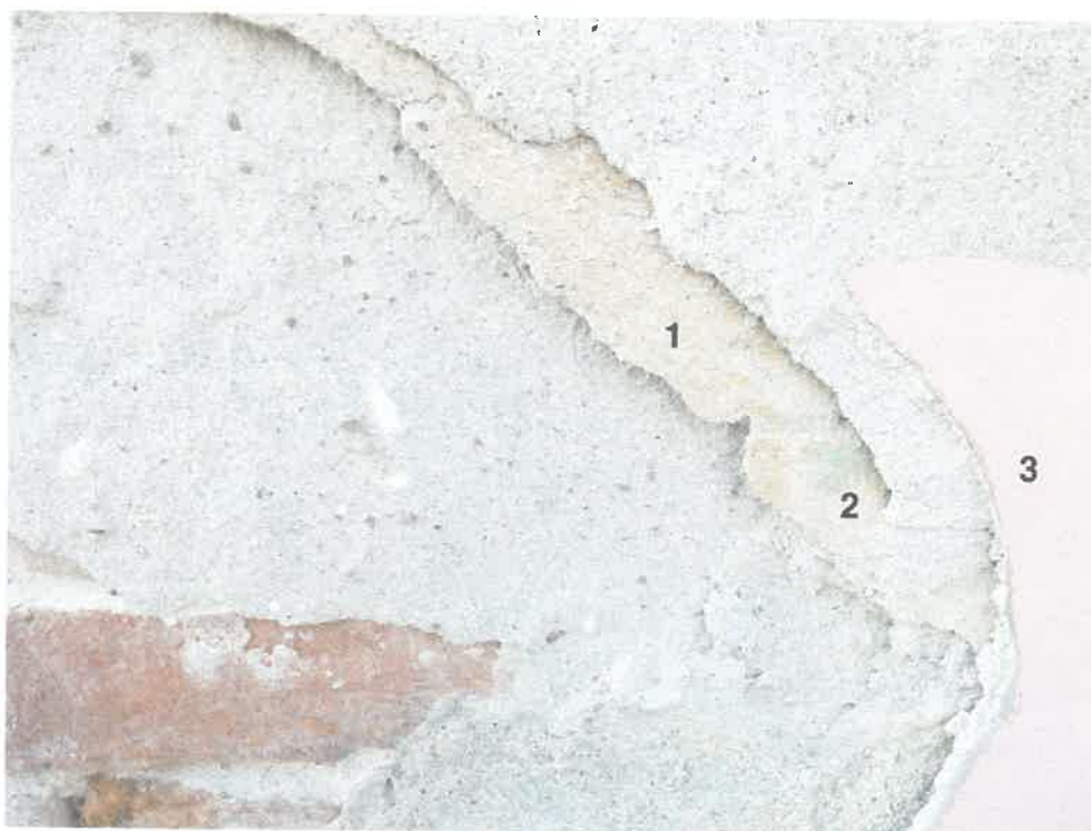
Odkrywka ukazująca wcześniejsze powłoki malarskie pomarańczową (1) i zieloną (2) oraz obecną różową (3).
