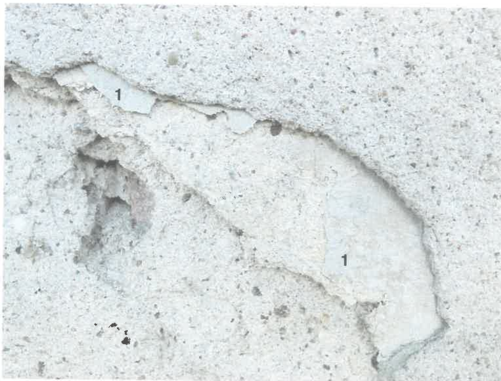
Szara powłoka malarska zbliżona do koloru S 168 z wzornika Keim Naturstein (1) odsłonięta na tynkach w obrębie elewacji frontowej od strony ul. Rybaki.
