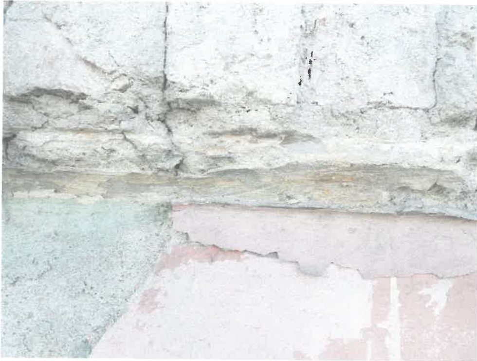
Zbliżenie na pozostałości profili odsloniętych w obrębie parapetu okiennego.
