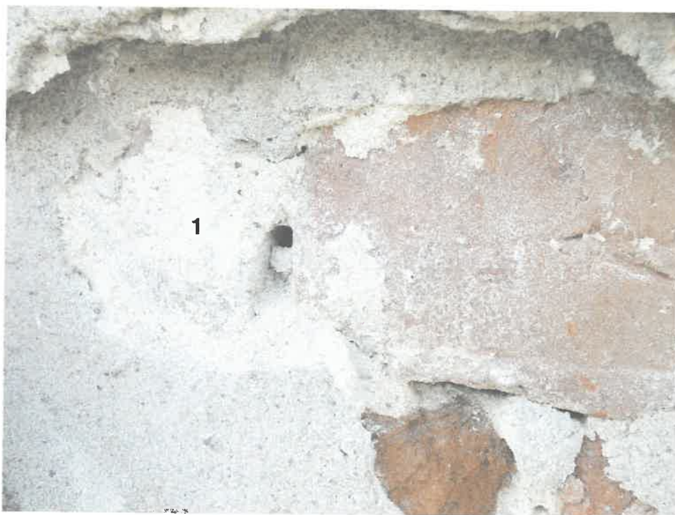
Odkrywka ukazująca pozostałość na cegle jasnej zaprawy wapiennej (1), zapewne pierwotnego tynku, który na przestrzeni istnienia obiektu został wymieniony.
