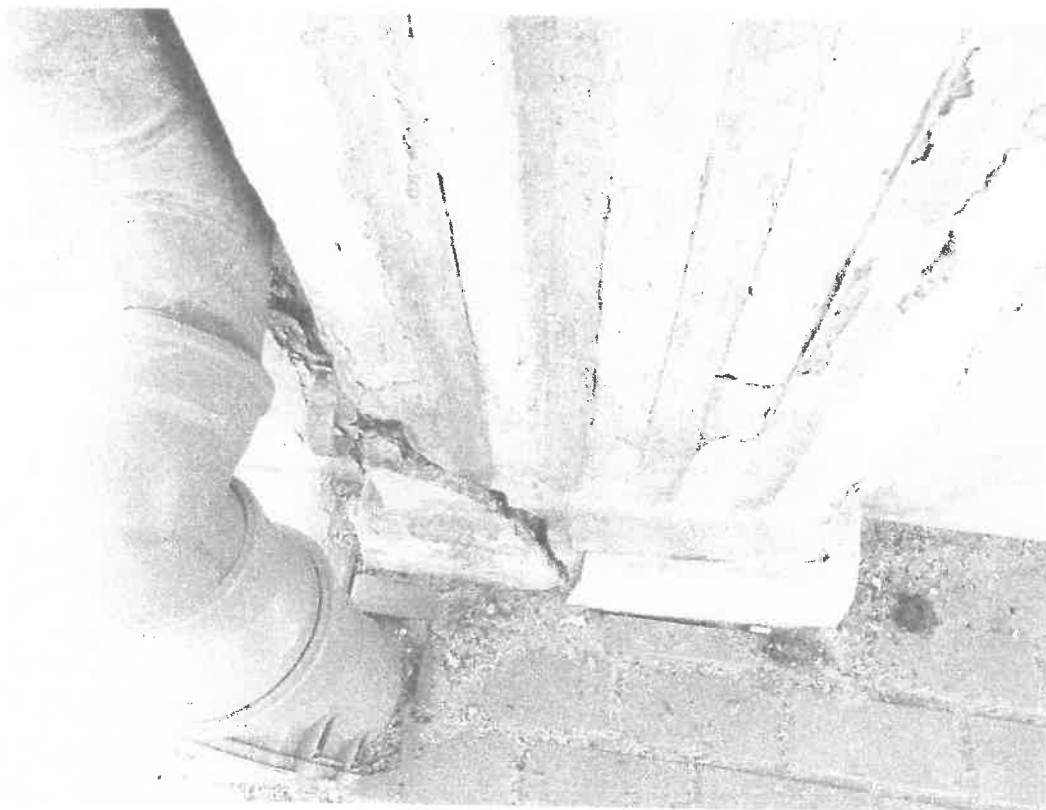
Fot. 4 Zbliżenie na ubytki i zniszczenie detalu architektonicznego.
