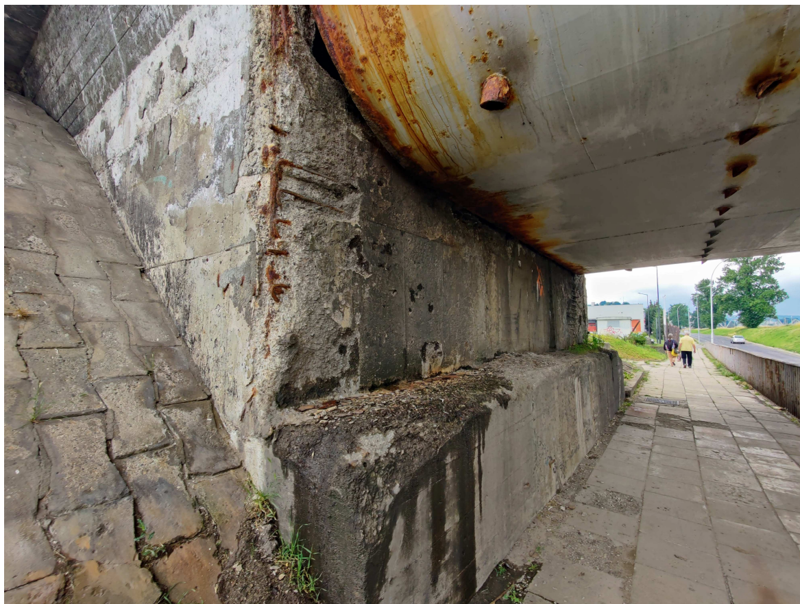
Fot. 27. Przyciółek od strony ul. Bohaterów Getta.
