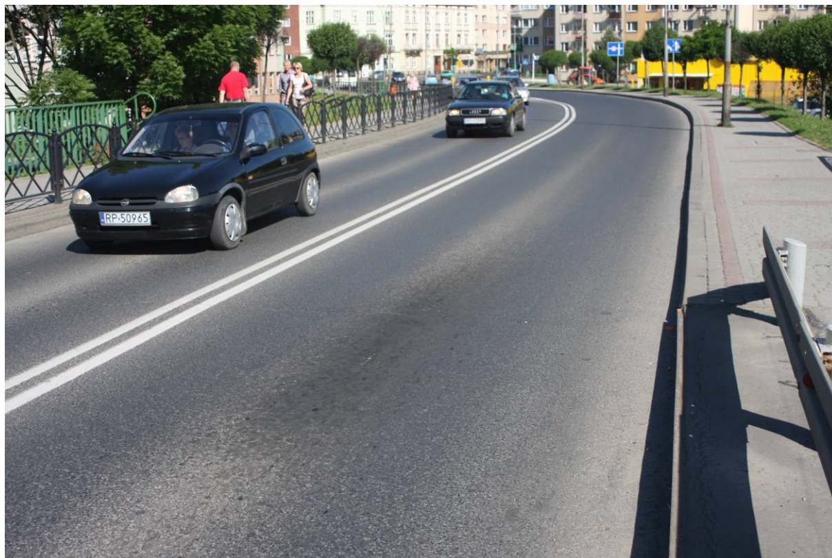
Fot. 7. Widok na dojazd od strony ul. Borelowskiego .
