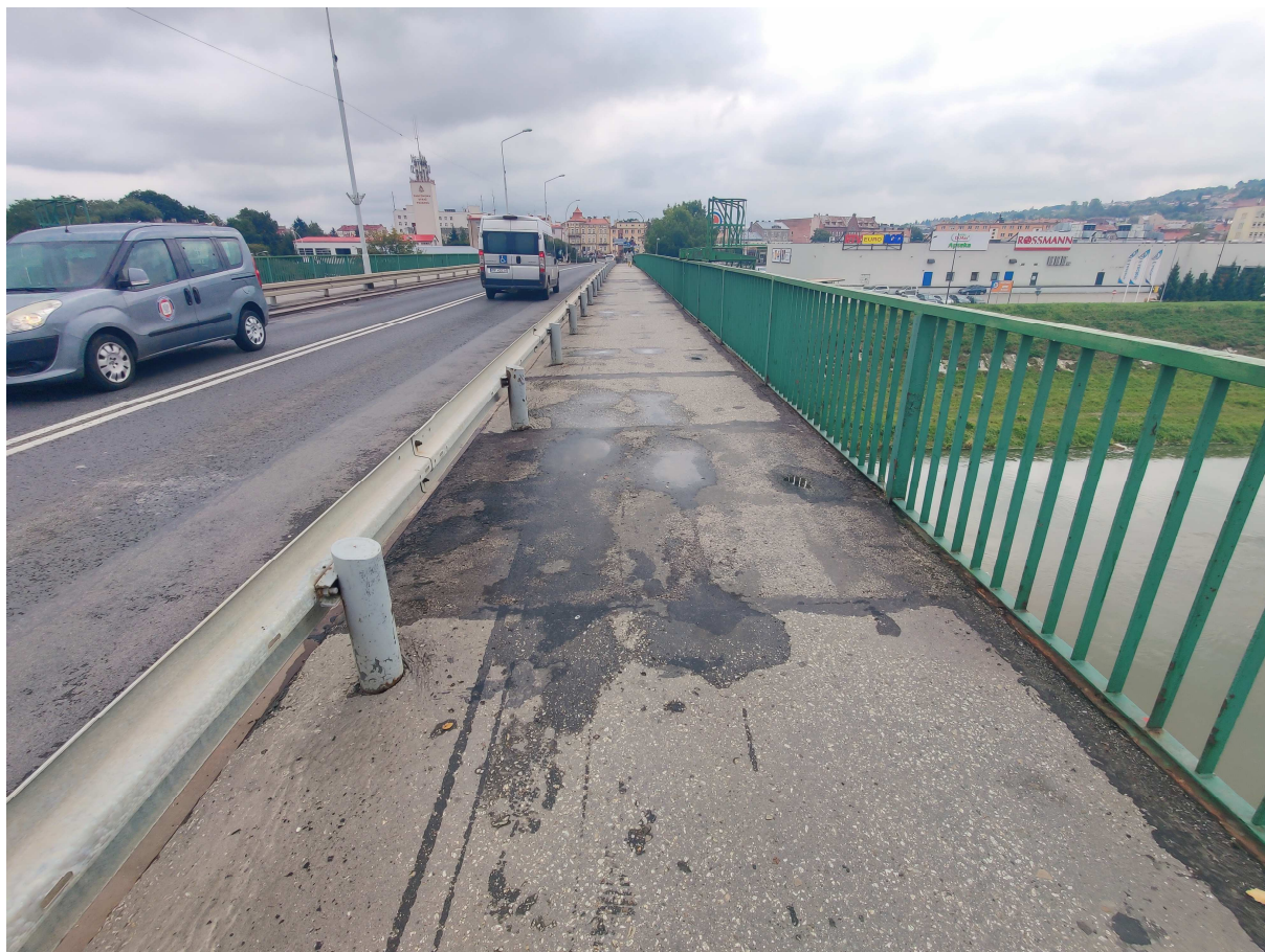
Fot. 9. Chodnik od strony górnej wody .
