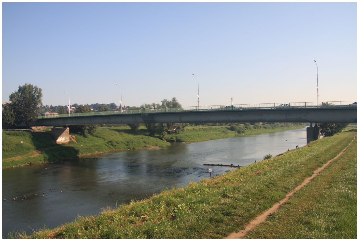
Fot. 5. Przestrzeń podmostowa
