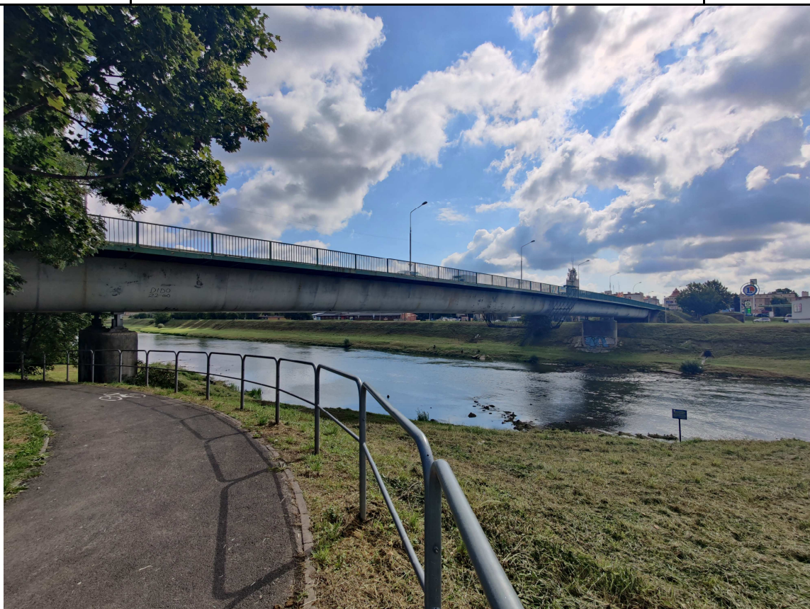
Fot. 1. Widok z boku od strony górnej wody (strona południowa)
