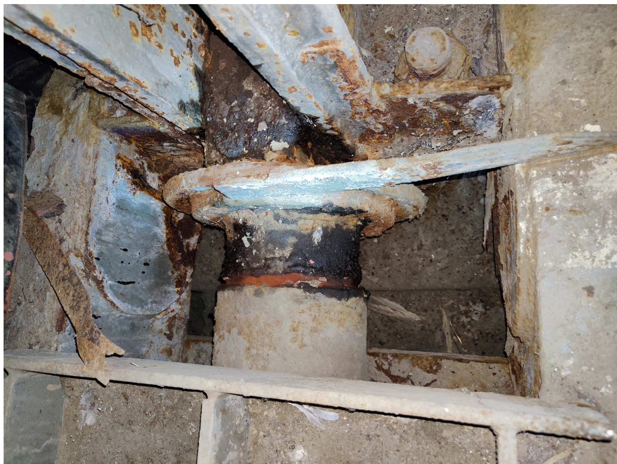
Fot. 47 Łożysko – zderzak w przyczółku
