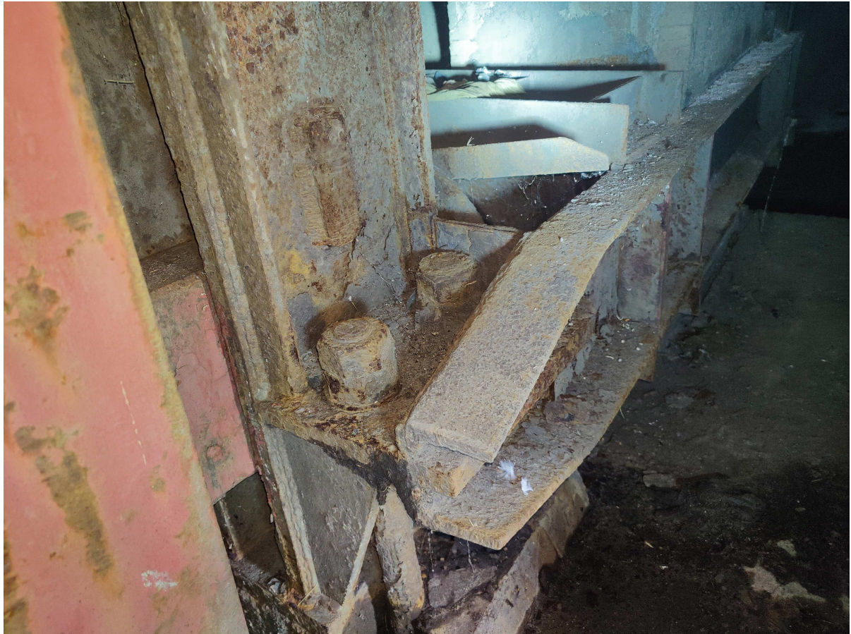
Fot. 46. Łożysko – zderzak w przyczółku.
