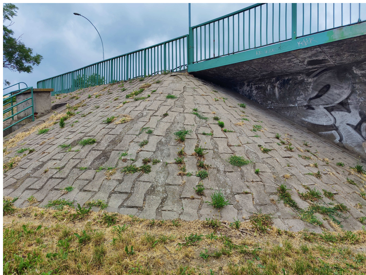
Fot. 75. Stożek przyczółka
