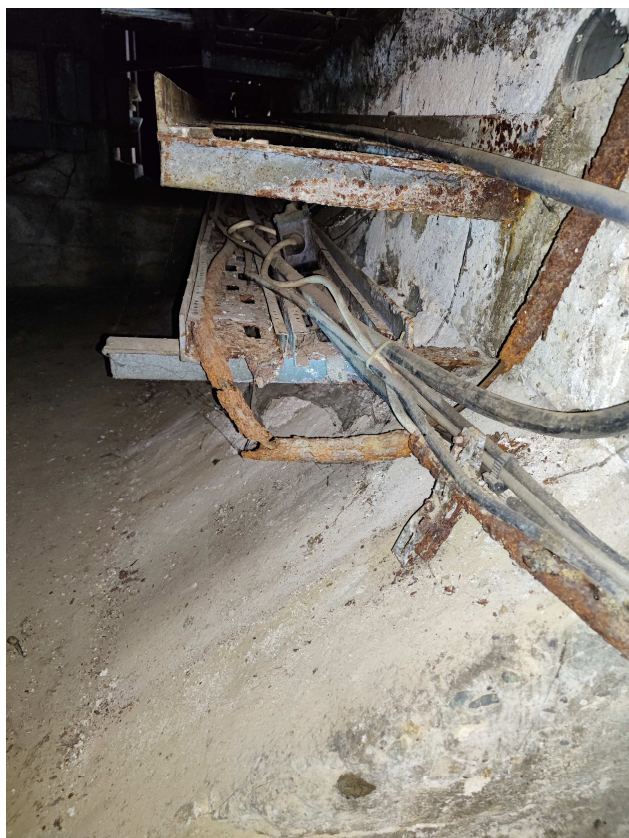
Fot. 55/56 Korozja konstrukcji w strefie przy dylatacji
