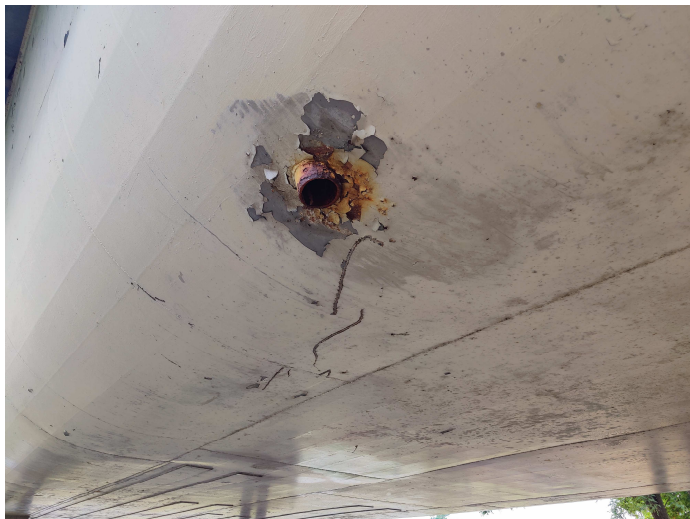
Fot. 25/26. Stan rur spustowych na zewnątrz i wewnątrz konstrukcji mostu
