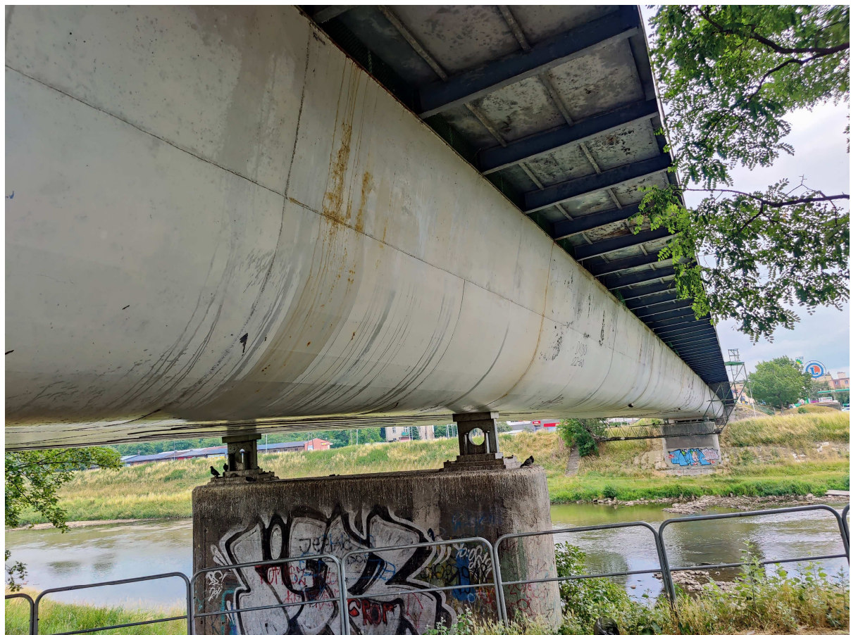
Fot. 43 Stan konstrukcji mostu
