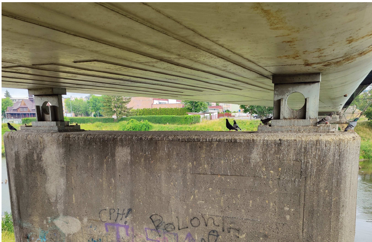
Fot. 45 Łożyska na filarze od strony ul. Bohaterów Getta
