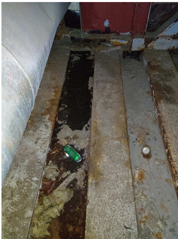
Fot. 55/56 Korozja konstrukcji w strefie przy dylatacji
