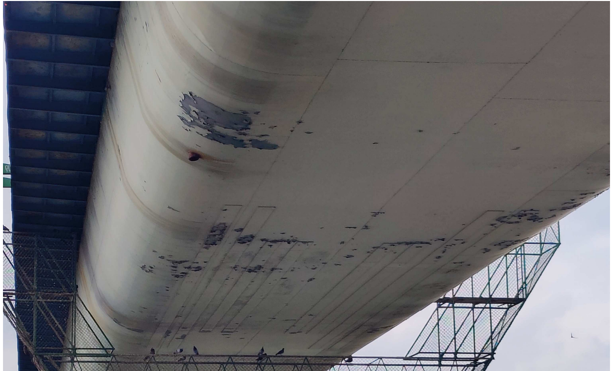
Fot. 42. Stan konstrukcji mostu.
