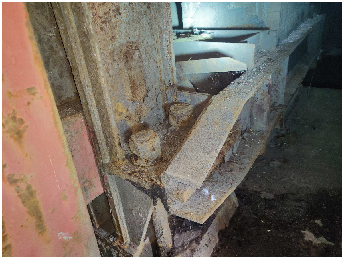
Fot. 46. Łożysko – zderzak w przyczółku.
