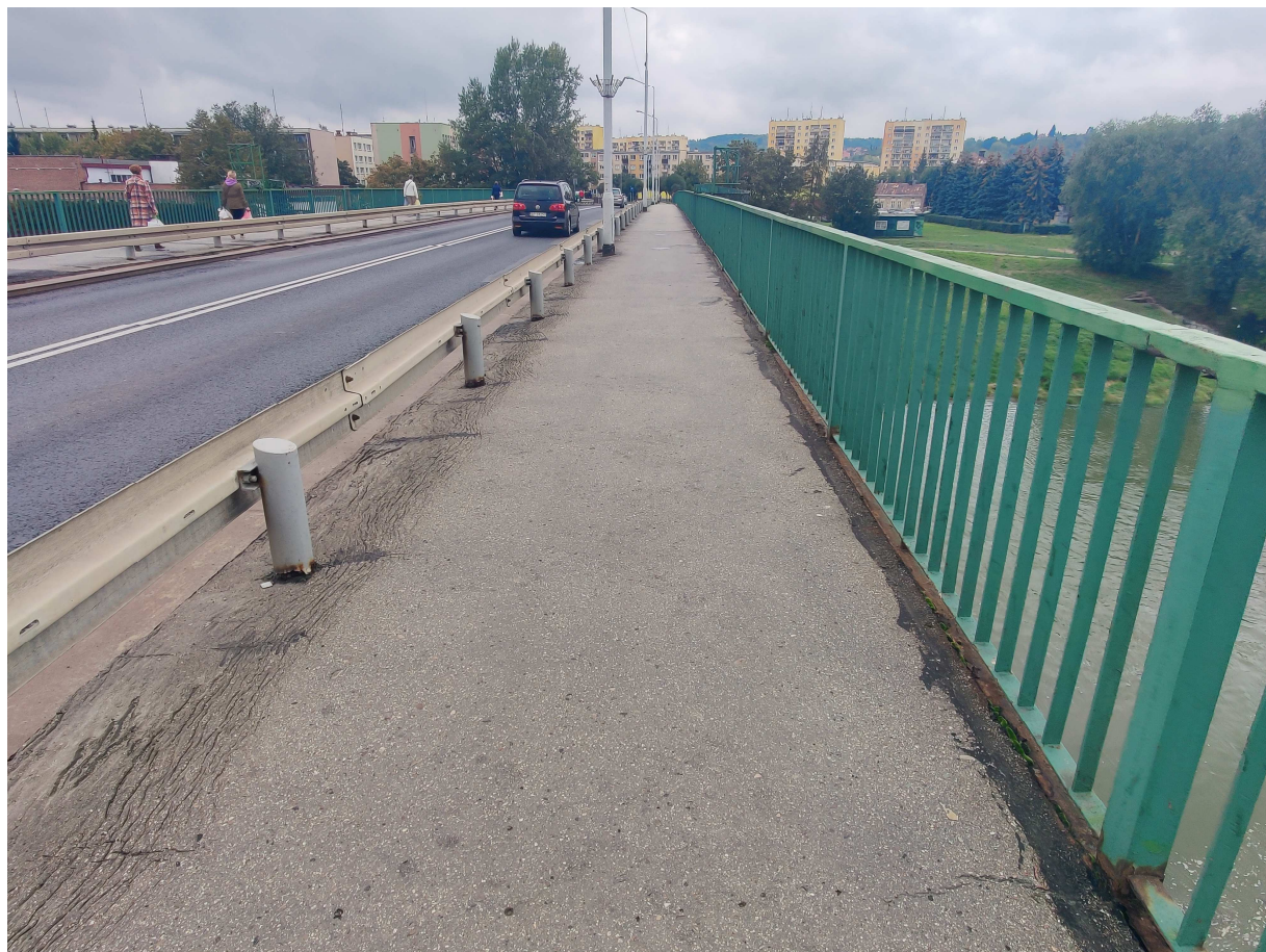
Fot. 11. Chodnik od strony dolnej wody .
