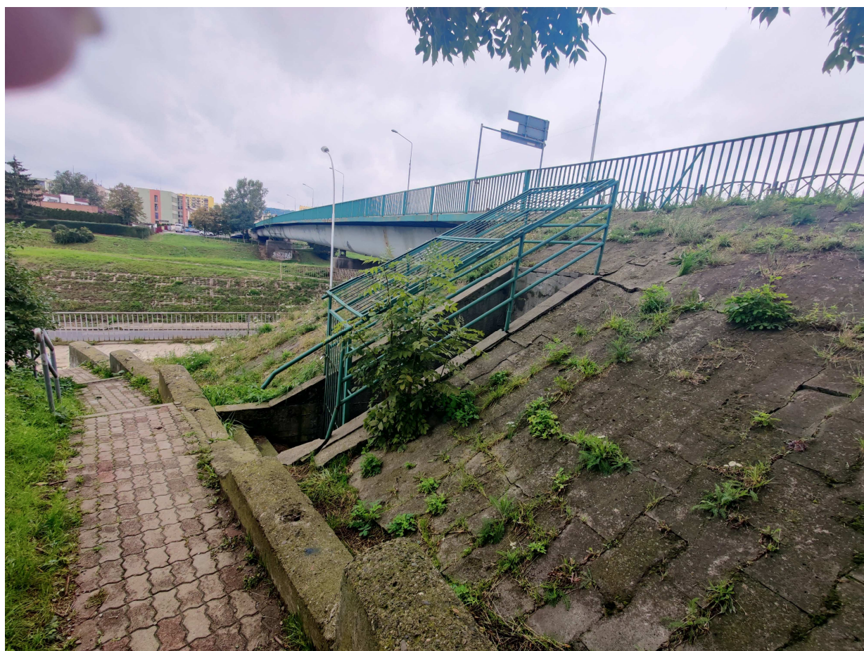
Fot. 73. Umocnienie skarpy
