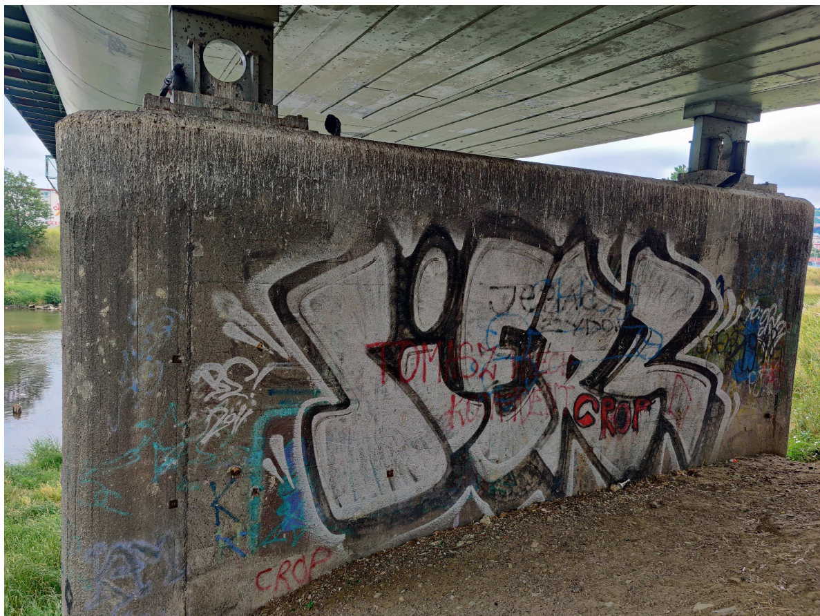
Fot. 35. Filar od strony ul. Borelowskiego.
