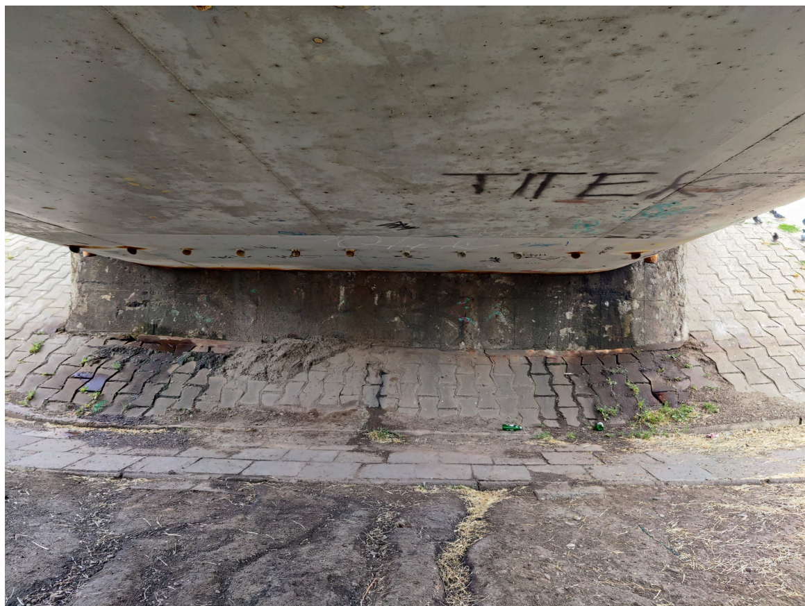
Fot. 34. Przyczółek od strony ul. Borelowskiego.
