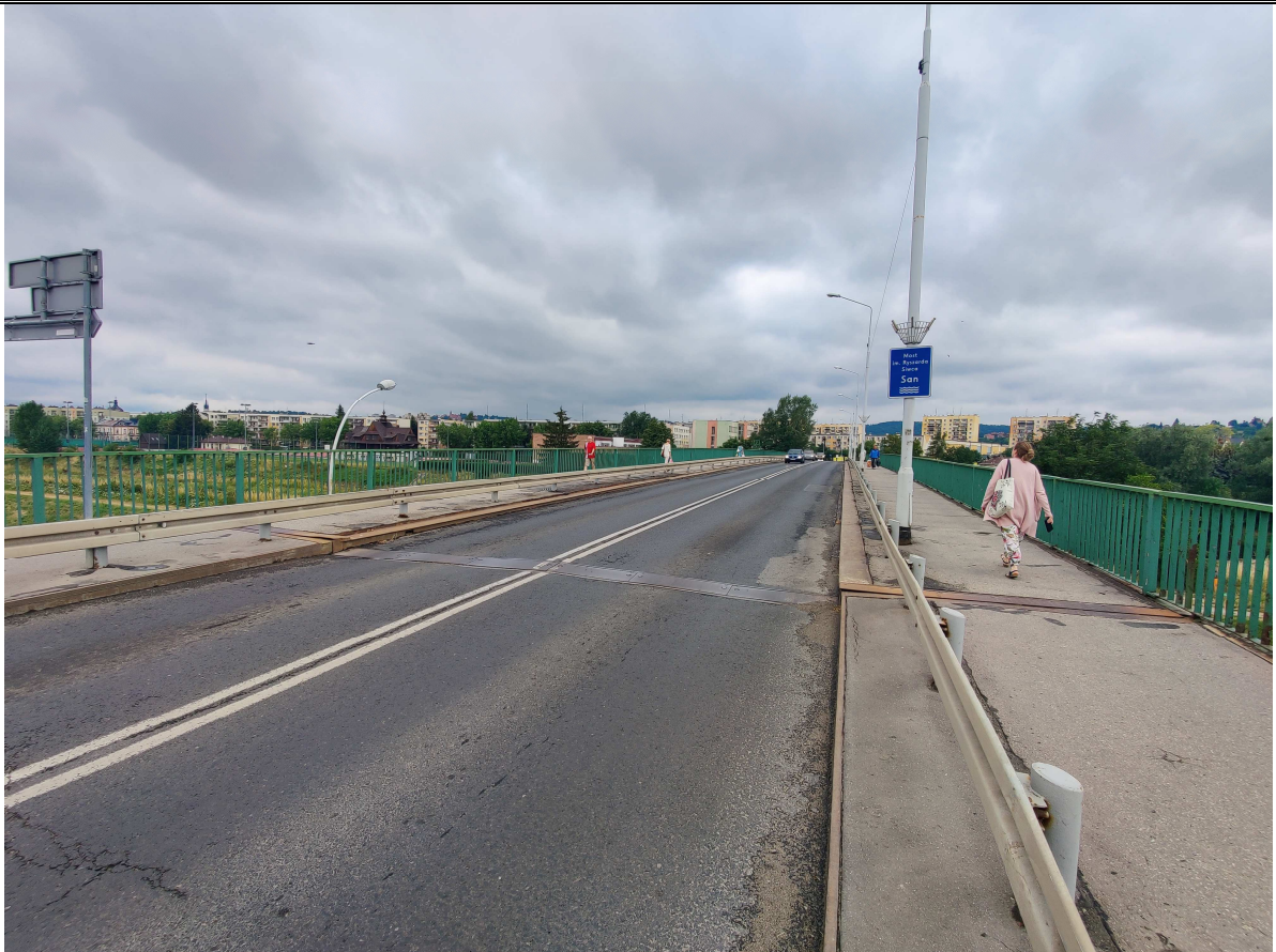
Fot. 3. Widok na most od strony ul. Bohaterów Getta
