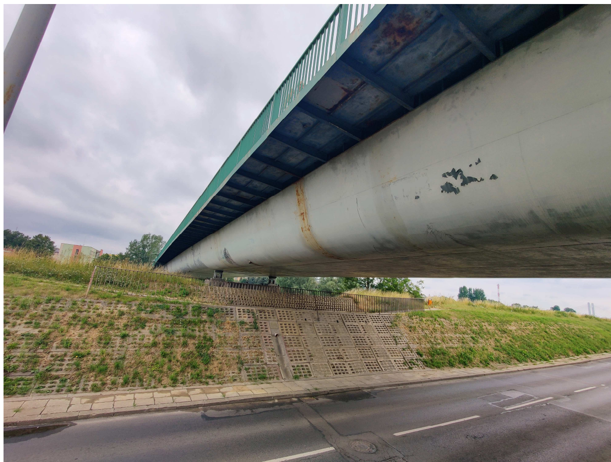
Fot. 41 Stan konstrukcji mostu
