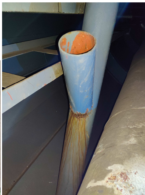
Fot. 25/26. Stan rur spustowych na zewnątrz i wewnątrz konstrukcji mostu
