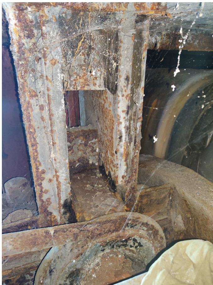
Fot. 48. Łożysko – zderzak w przyczółku.
