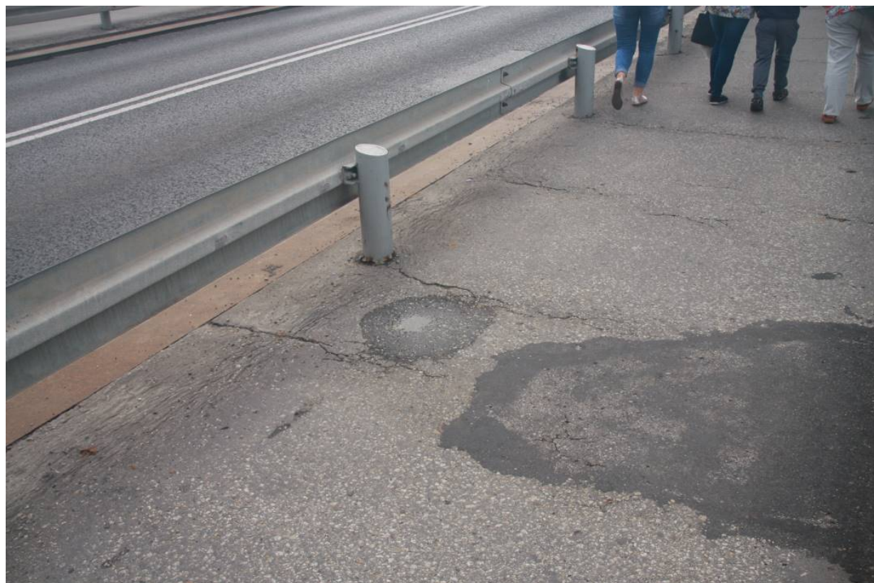
Fot. 12. Chodnik od strony dolnej wody
