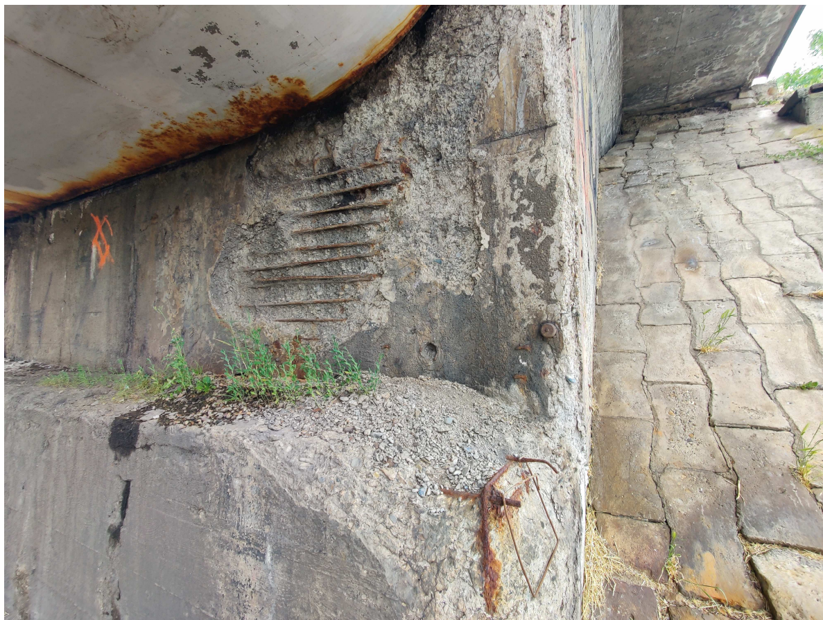
Fot. 29. Przyciółek od strony ul. Bohaterów Getta.
