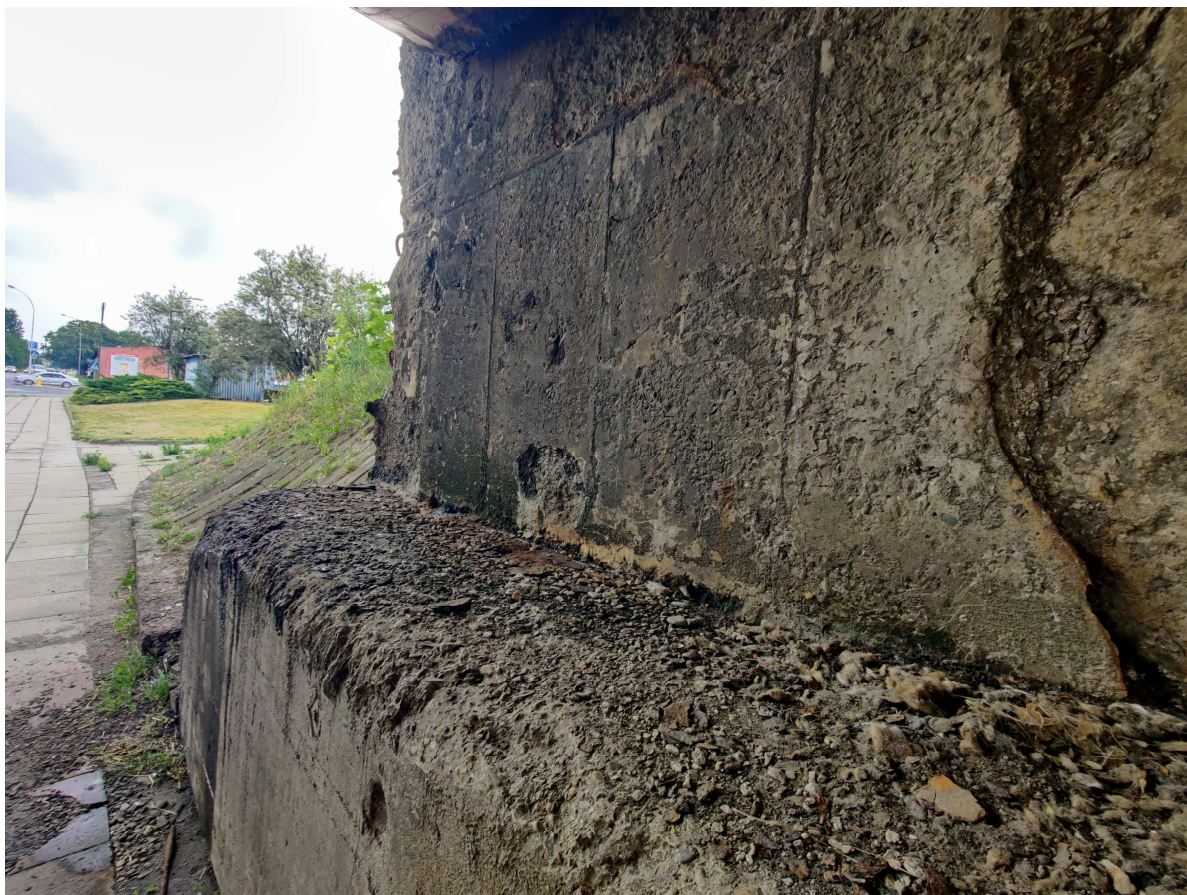
Fot. 28. Przyciółek od strony ul. Bohaterów Getta.
