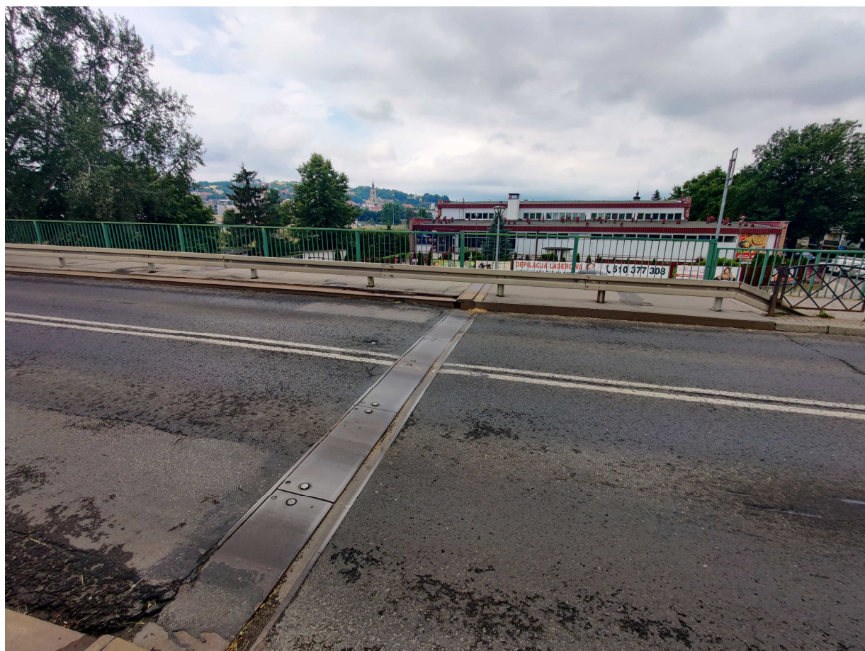
Fot. 14. Urządzenie dylatacyjne od strony ul. Borelowskiego
