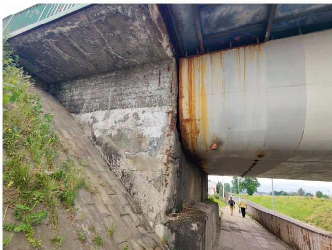
Fot. 39/40. Stan konstrukcji w obrębie dylatacji.
