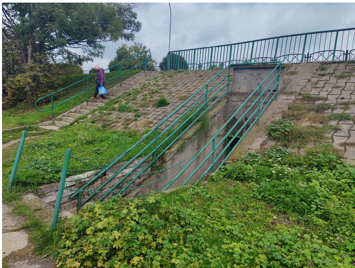
Fot. 71. Wejście do przyczółka
