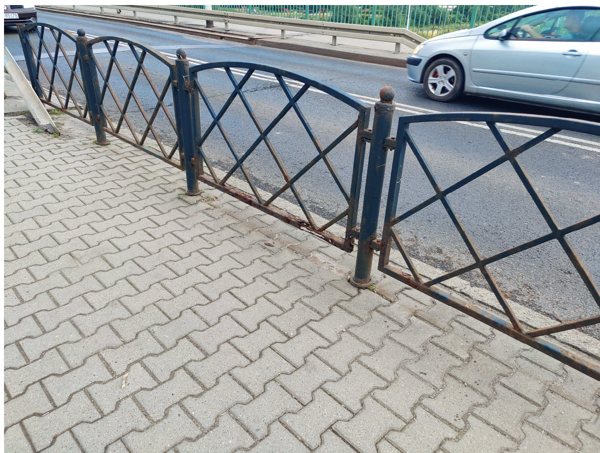
Fot. 64. Wygradzenia na dojazdach do mostu
