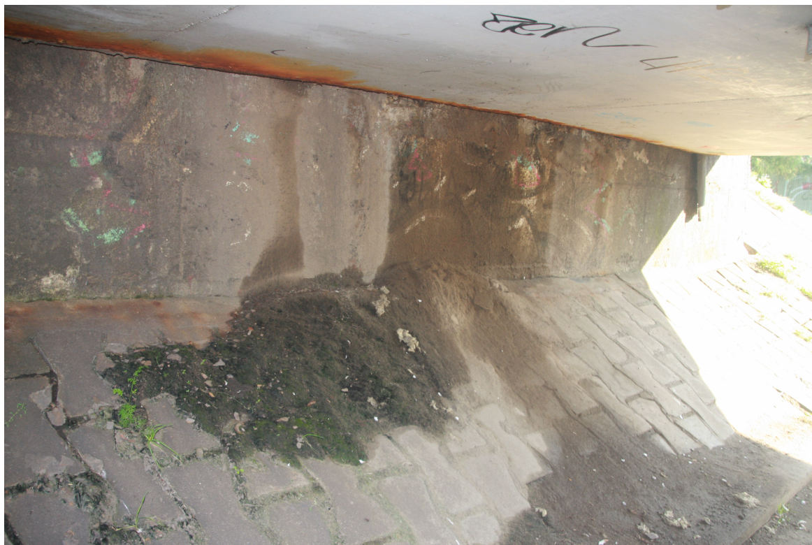
Fot. 33. Przyczółek od strony ul. Borelowskiego.
