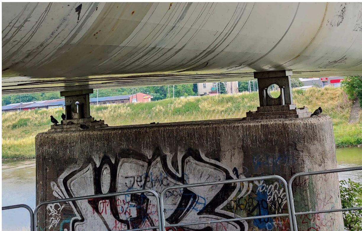
Fot. 44. Łożyska na filarze od strony ul. Borelowskiego.
