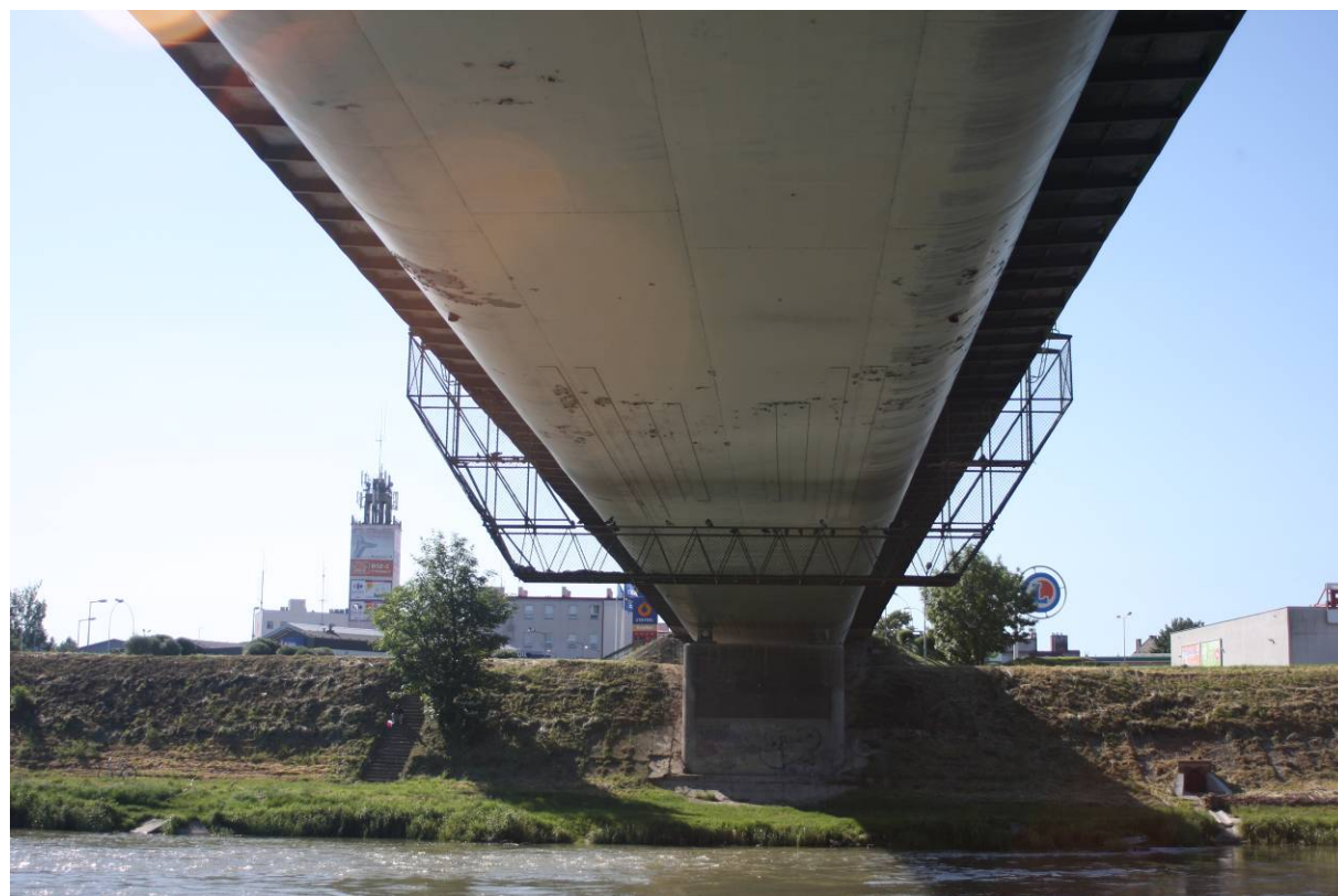
Fot. 6. Widok spodu konstrukcji
