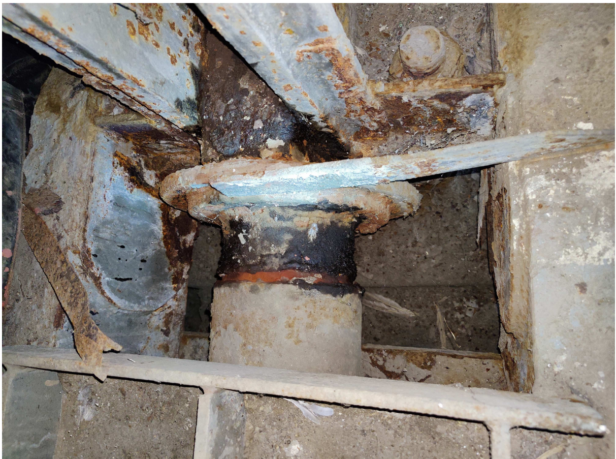
Fot. 47 Łożysko – zderzak w przyczółku
