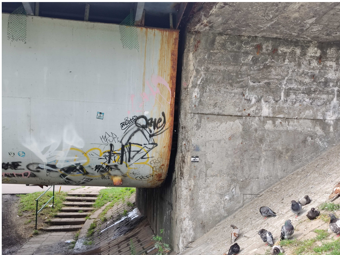
Fot. 32. Przyczółek od strony ul. Borelowskiego.
