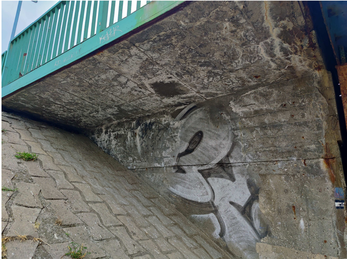
Fot. 31. Przyczółek od strony ul. Borelowskiego.
