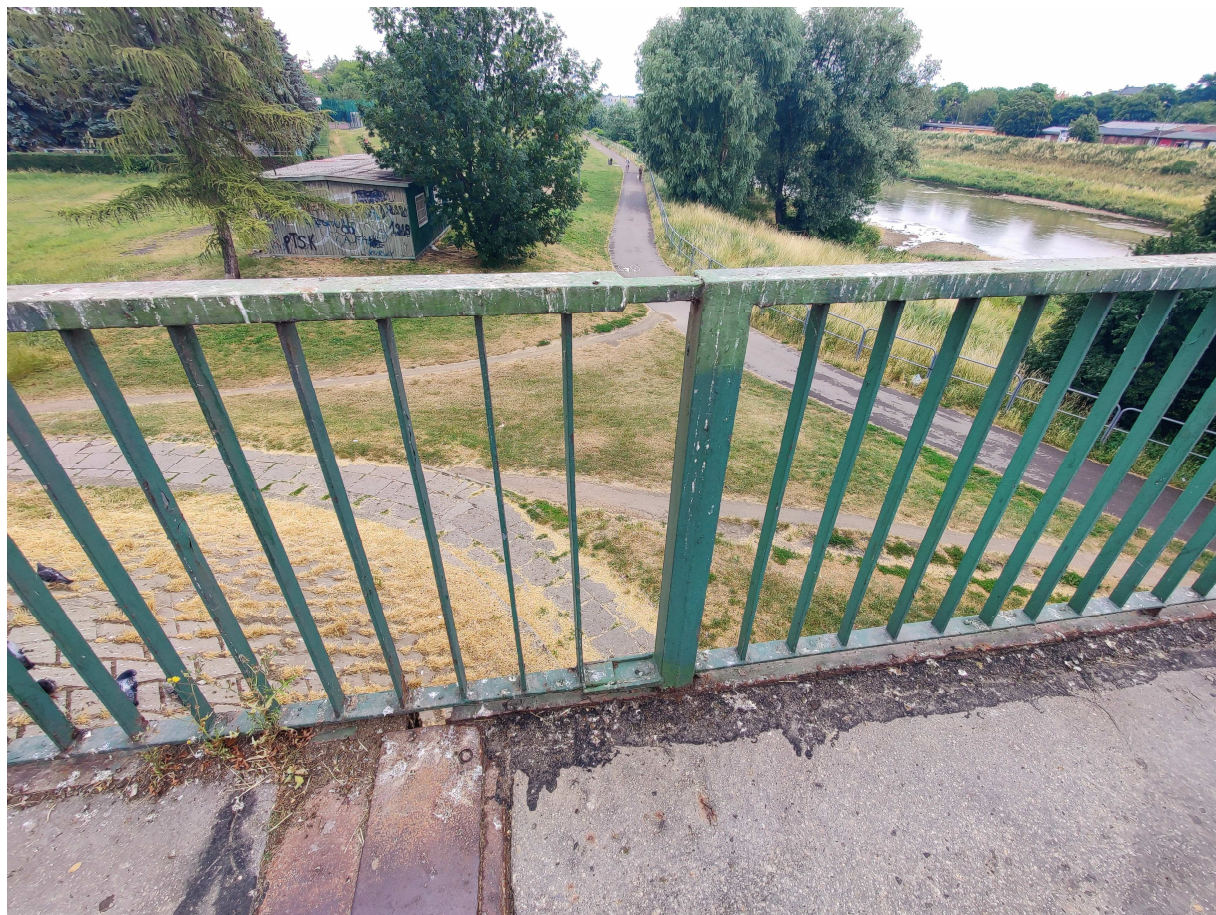
Fot. 19. Stan balustrad .
