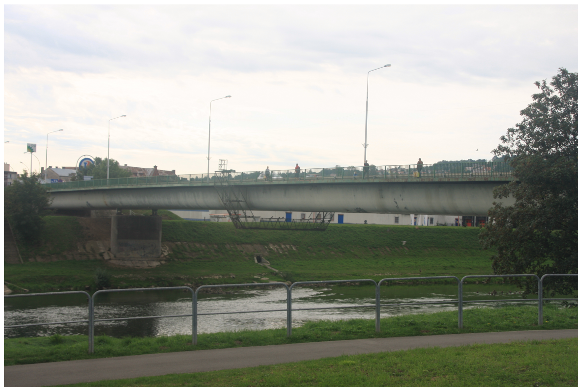
Fot. 2. Widok z boku od strony dolnej wody (strona północna)
