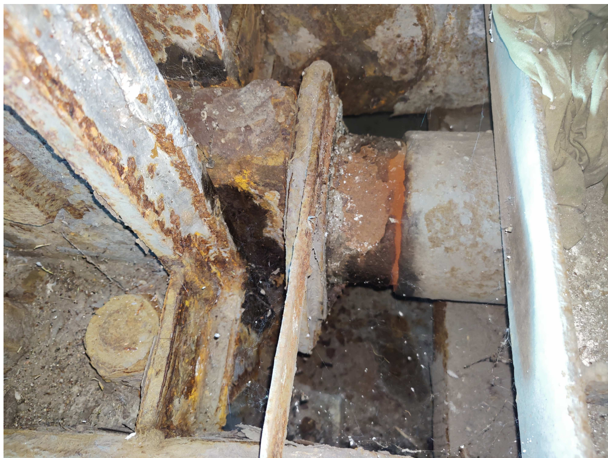
Fot. 49 Łożysko – zderzak w przyczółku
