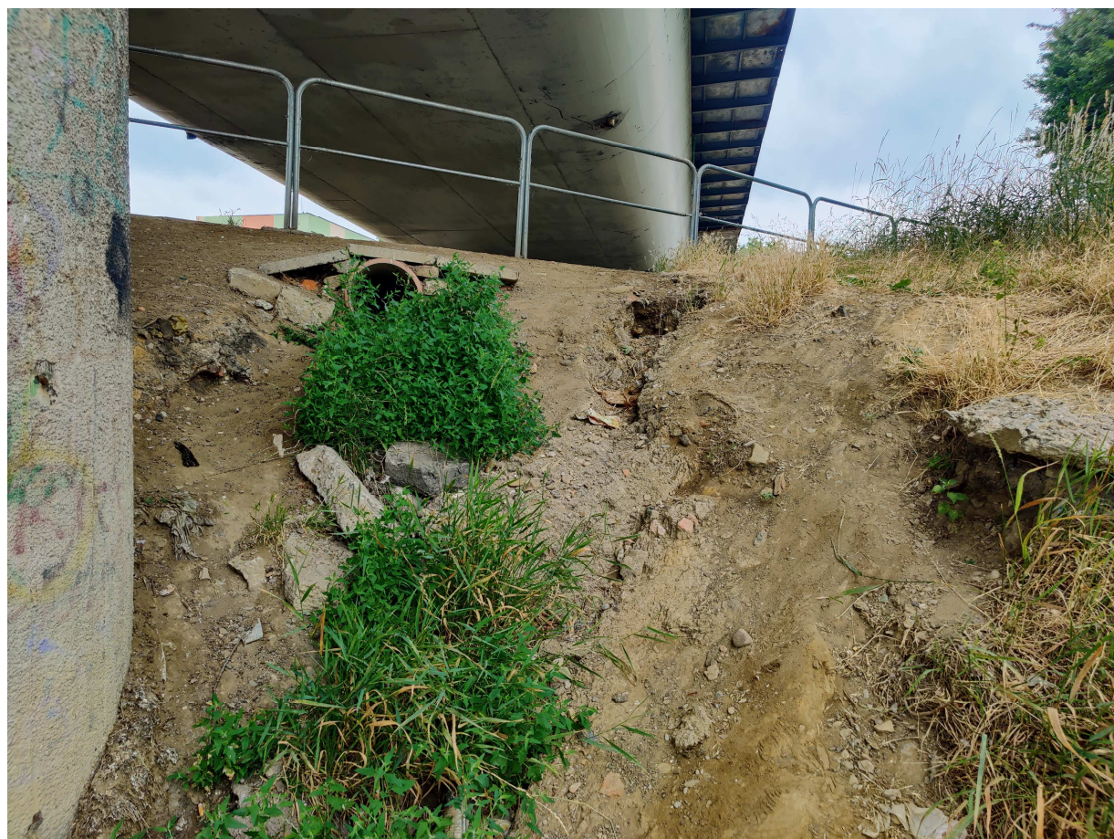
Fot. 75. Wyplukania skarpy przy filarze
