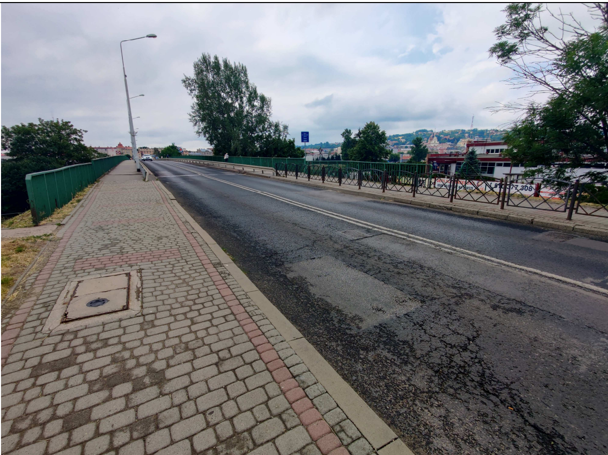
Fot. 4. Widok na most od strony ul. Borelowskiego
