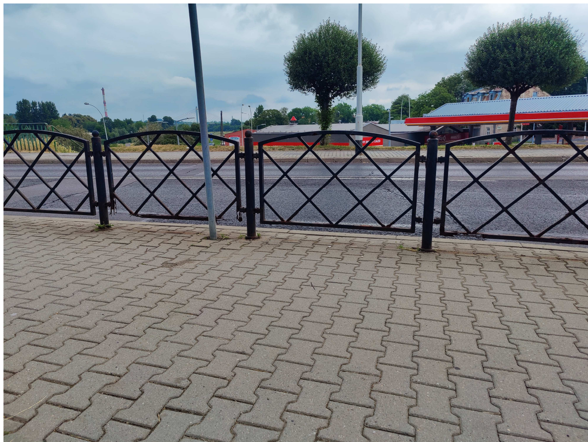
Fot. 63. Wygradzenia na dojazdach do mostu
