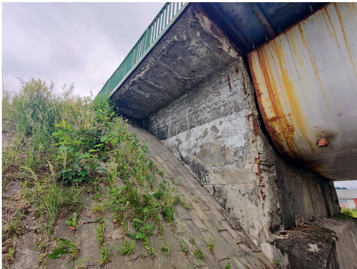
Fot. 30. Przyciółek od strony ul. Bohaterów Getta.
