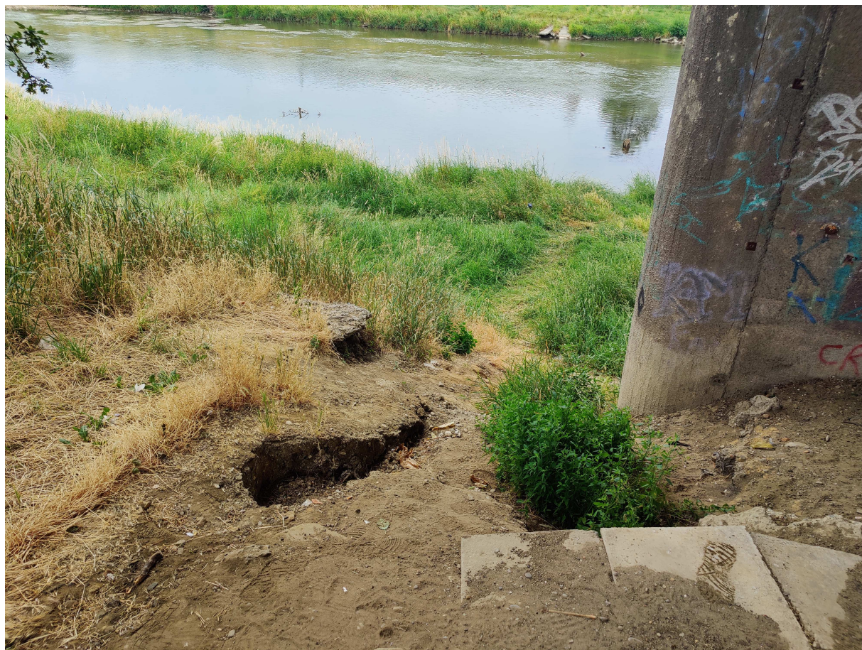
Fot. 74. Wyplukania skarpy przy filarze
