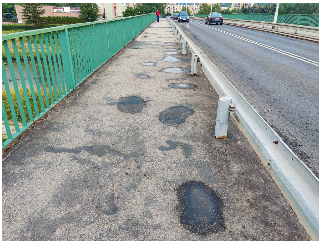
Fot. 10. Chodnik od strony górnej wody
