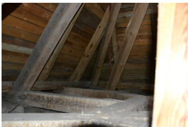
Widok konstrukcji więźby nad wieżą.
