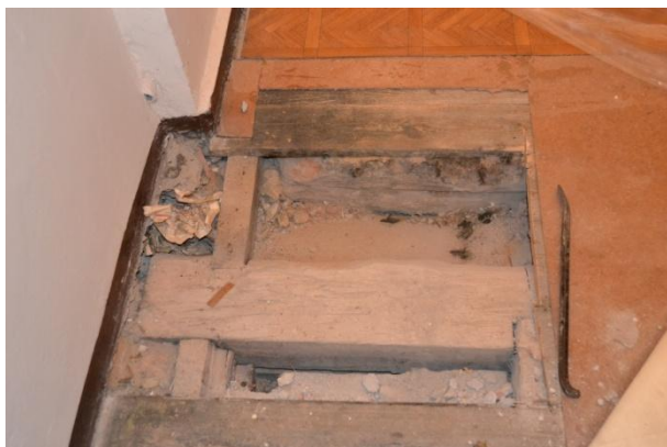
Widok odkrytego stropu nad parterem.
