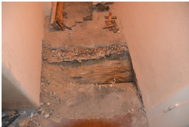
Widok odkrytego stropu nad II piętrem.
