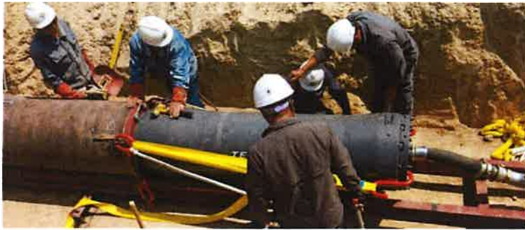
Rys. 29. Przecisk z ubijakiem umieszczonym za rurą stalową
