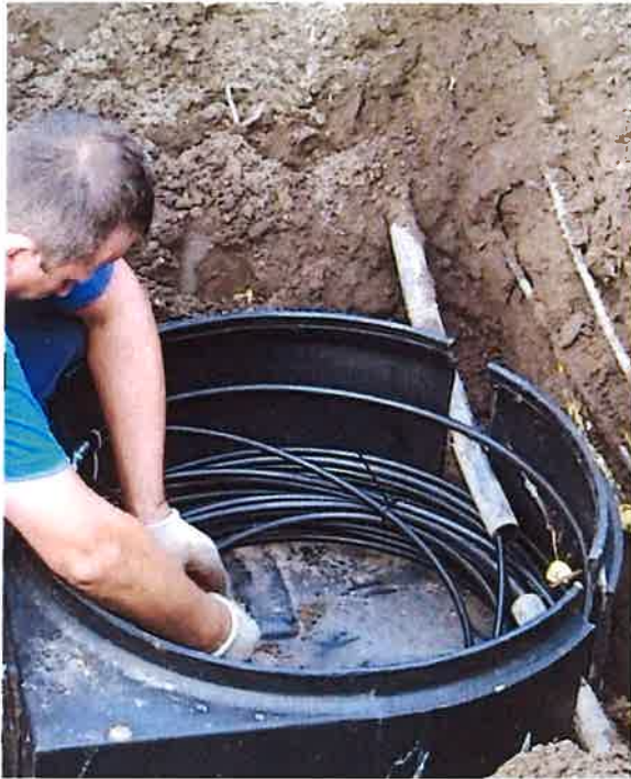
Rys. 38. Końce przeciętej rury osłonowej zostały wprowadzone do zasobnika. Na dnie zasobnika ułożono zwinięty zapas kabla
