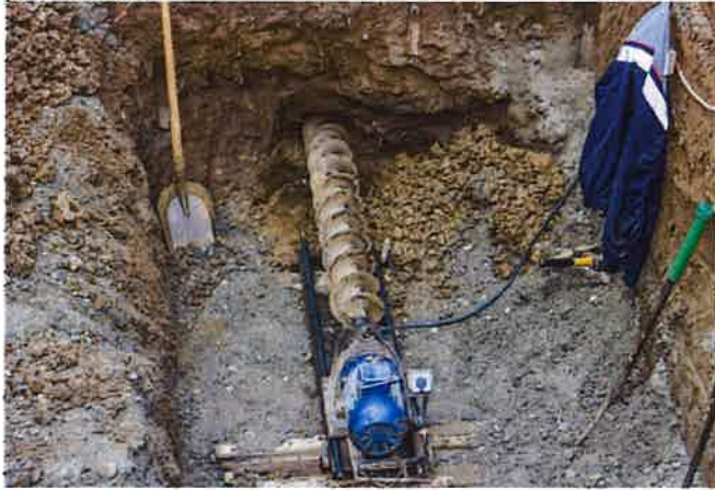
Rys. 31. Wykonywanie przewiertu
