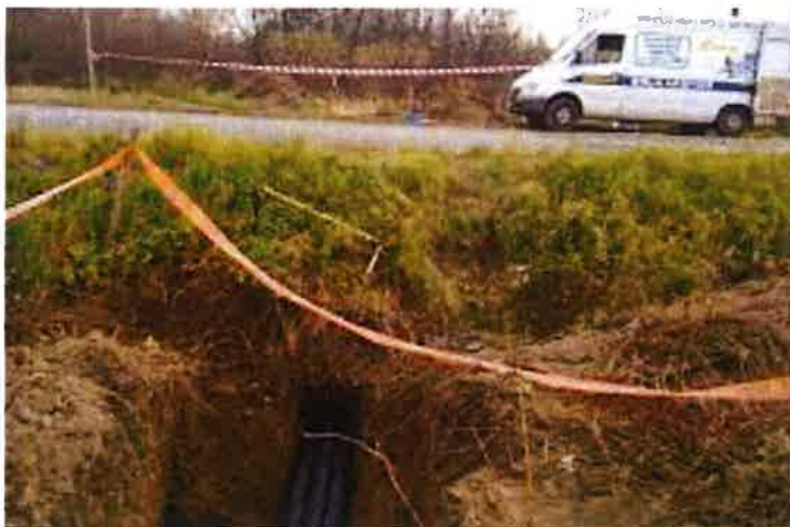
Rys. 32. Kanał kablowy umieszczony metodą przewiertu
