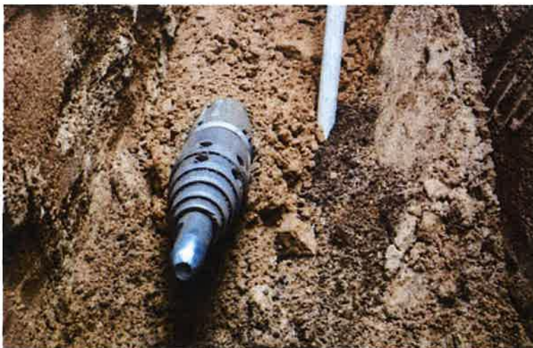
Rys. 28. Kret ciągnący rurę
