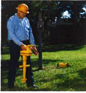
Rys. 41. Lokalizowanie i pomiar głębokości znaczników elektromagnetycznych
