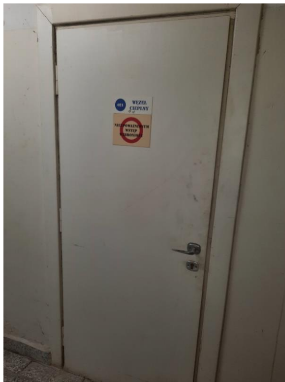
Istniejące drzwi do węzła cieplnego podlegające wymianie
