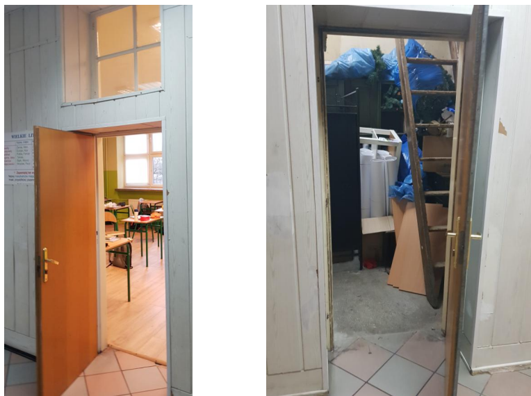
Widok istniejącej stolarki drzwiowej
