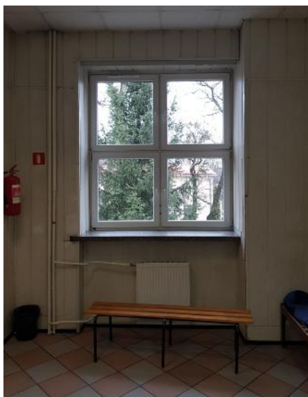
Widok okna do przebudowy na otwór drzwiowy
