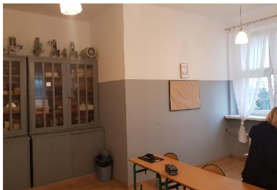
Ścianka działowa na III piętrze do rozbiórki
