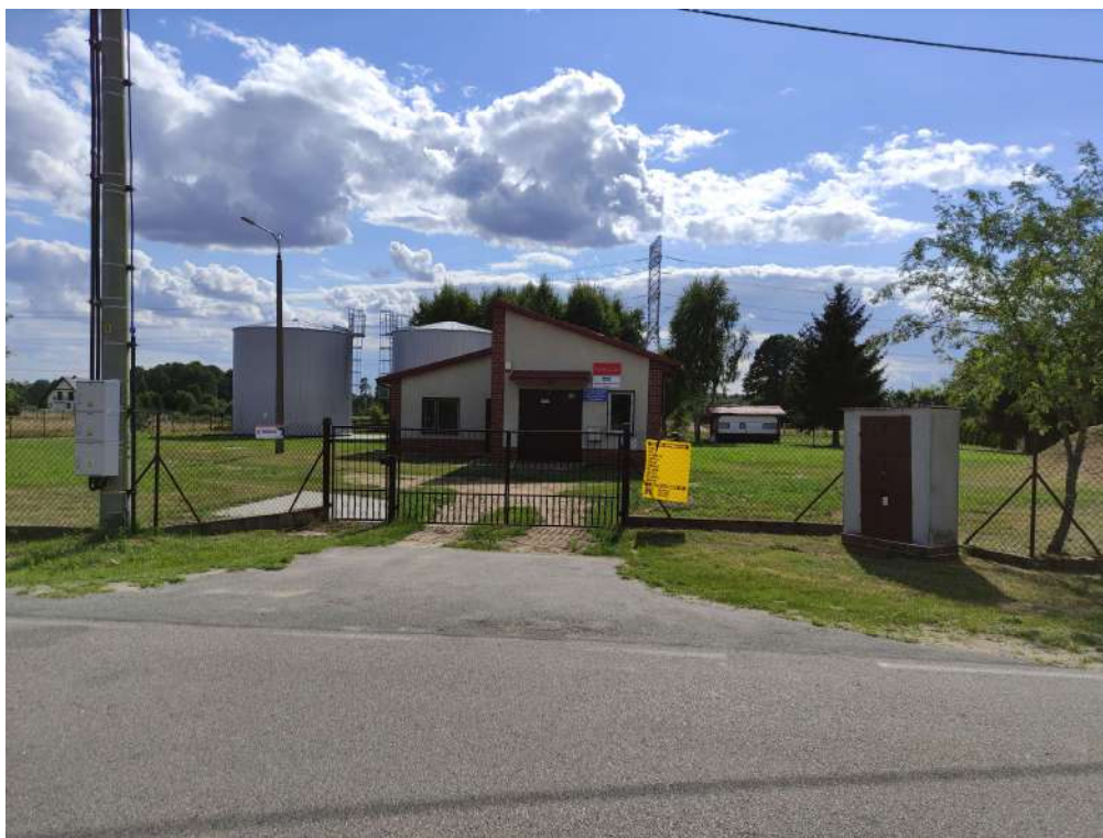
Fot. 2 – Punkt włączenia wodociągowej sieci tranzytowej w msc. Gnaty - SUW
