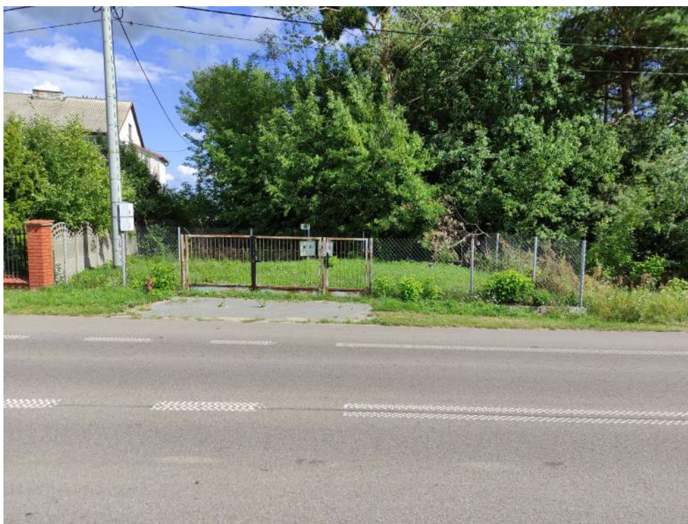
Fot. 3 – Istniejąca pompownia do modernizacji P4 – Łęg Przedmiejski
