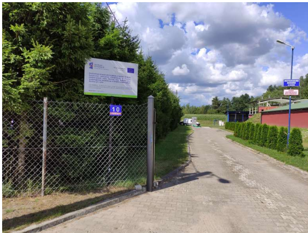
Fot. 11 Gminna oczyszczalnia ścieków – wjazd
