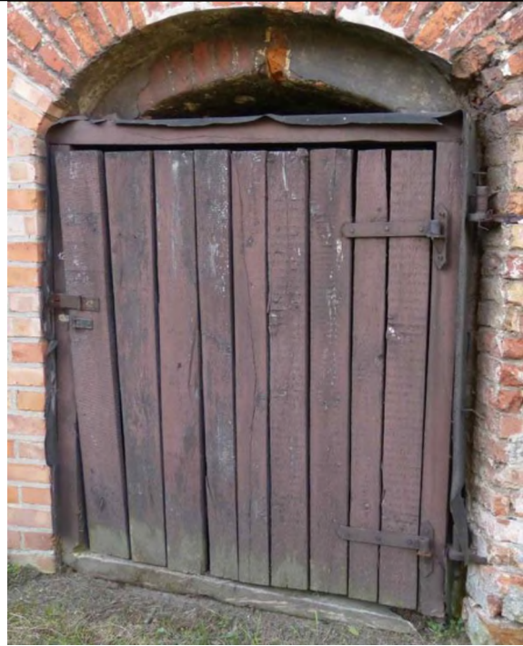
Prostokątne drzwi w półokrągłym otworze. Zachowane dawne haki. Do zawiasów.
