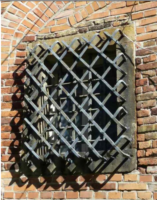
Okno w wieńcu z oryginalną kratą.
