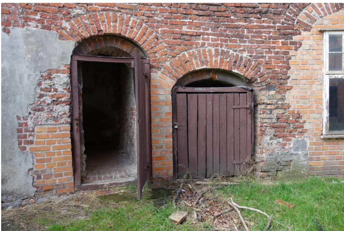
Stolarka w oryginalnych otworach drzwiowych wschodniej elewacji
