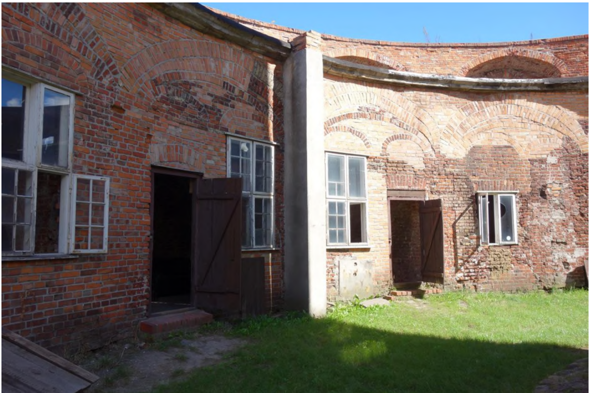
Zachodnia elewacja wieńca
