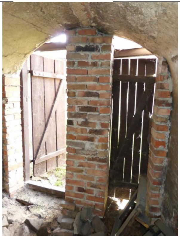
Prowizoryczne drzwi deskowe od strony wnętrza.
