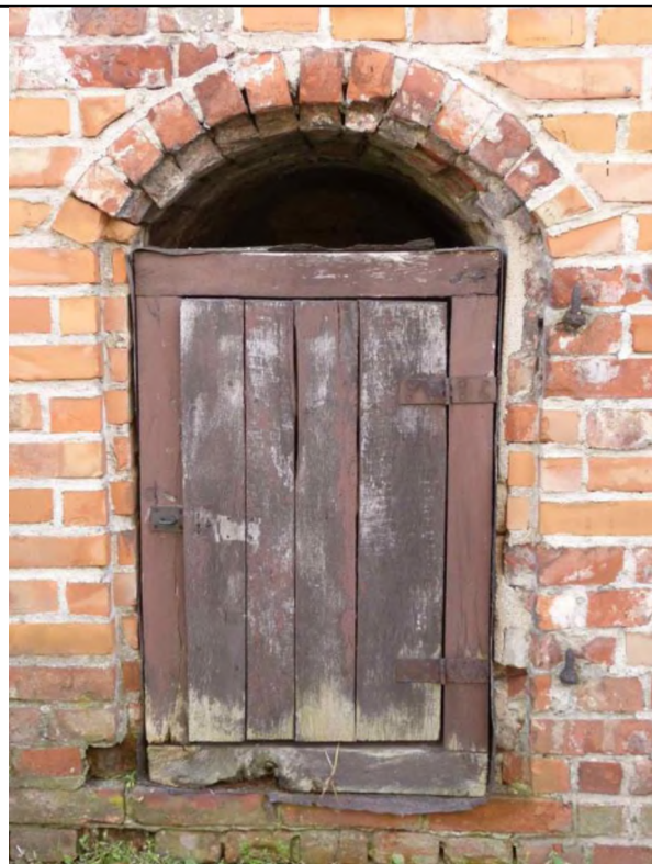
Małe drzwiczki do pomieszczenia – schowka. Zachowane oryginalne haki.
