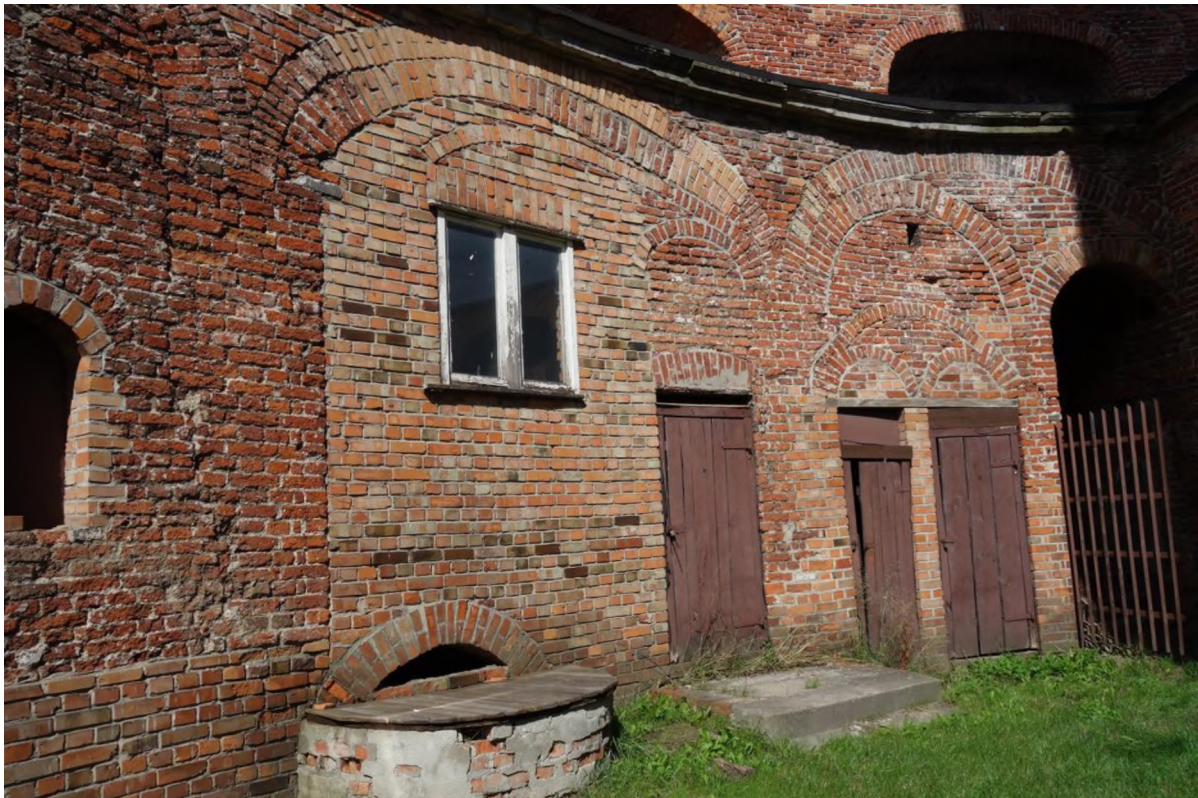
Południowa elewacja wieńca
