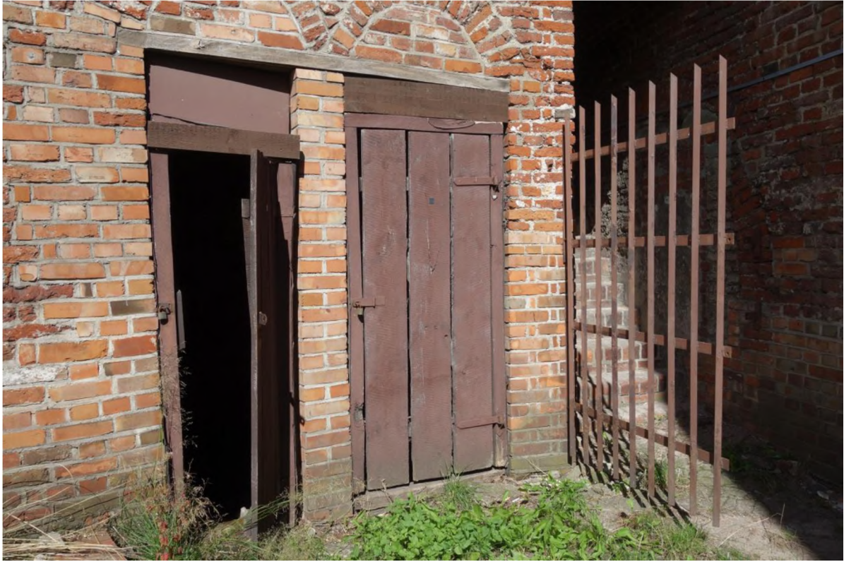
Stolarka drzewiowa w południowej elewacji
