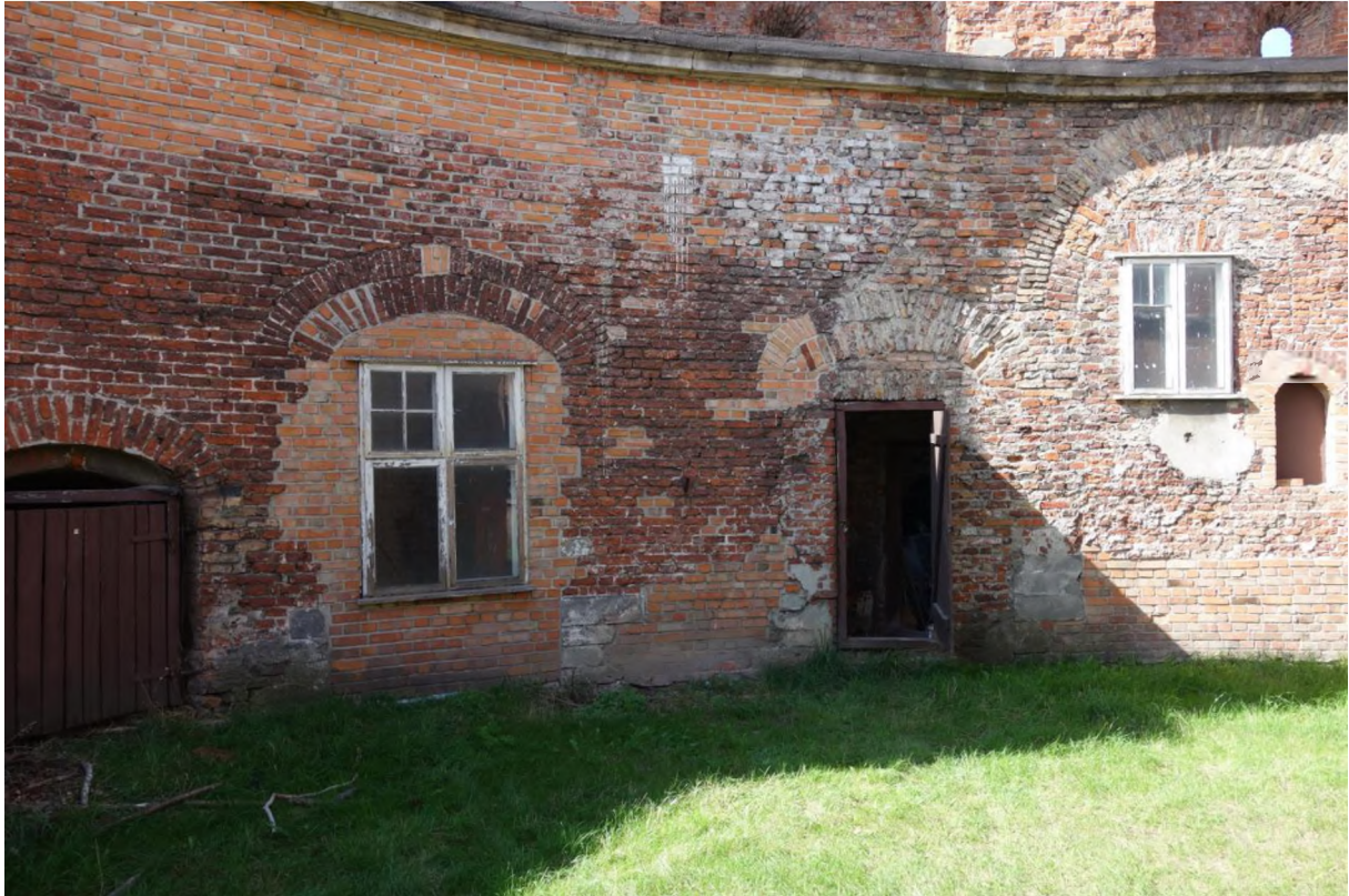
Południowa elewacja wieńca
