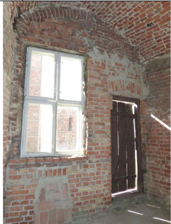
Okno i prowizoryczne drzwi
