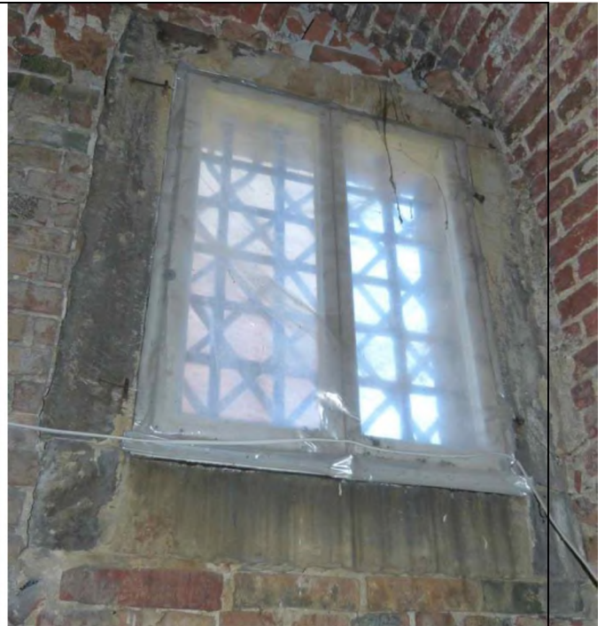
Okno z kratą od strony wnętrza. Widoczne haki po zawiasach i zakrętka.
