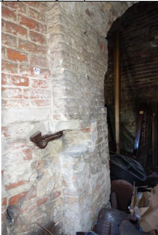
Zachwane gniazdo od zasuw wrót w przejeździe „igrekowym”
