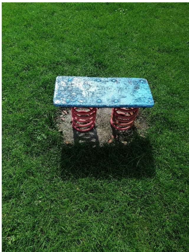
Zdjęcie sprężynowca – płyta –siedzisko do wymiany
